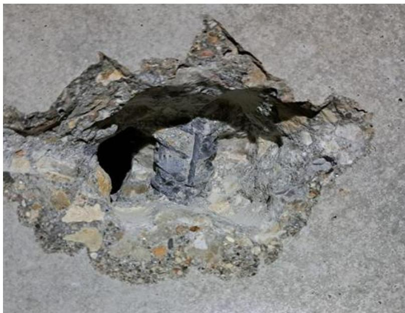
Рис. 1. Вид места определения армирования плит перекрытия
