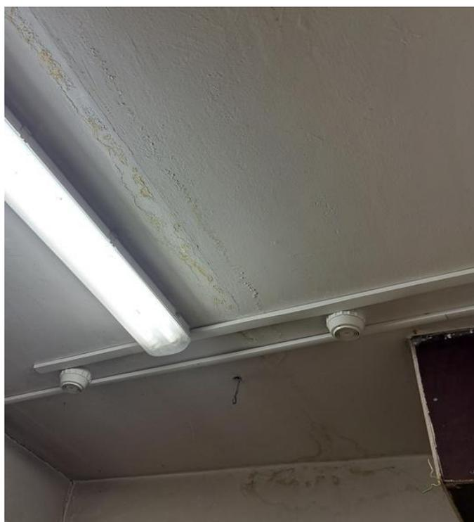
**Рис. 5. Вид места замочания плит перекрытия**
