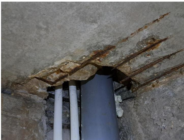
**Рис. 6. Вид отверстия в железобетонных плитах перекрытия и ржавления арматуры**
