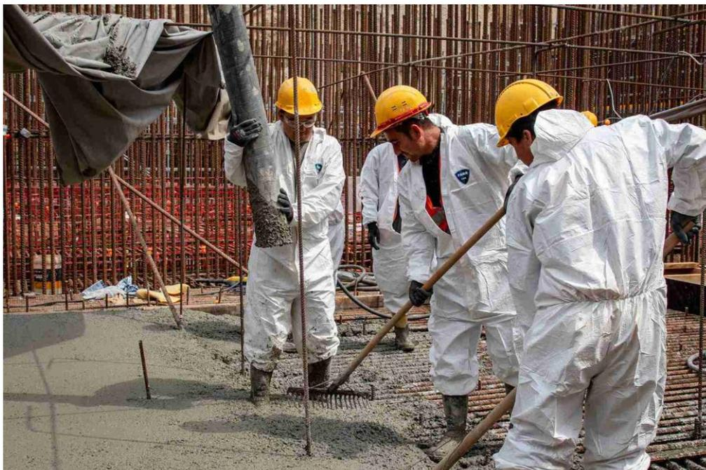
**Рис. 1. Процесс укладки и уплотнения бетонной смеси**
