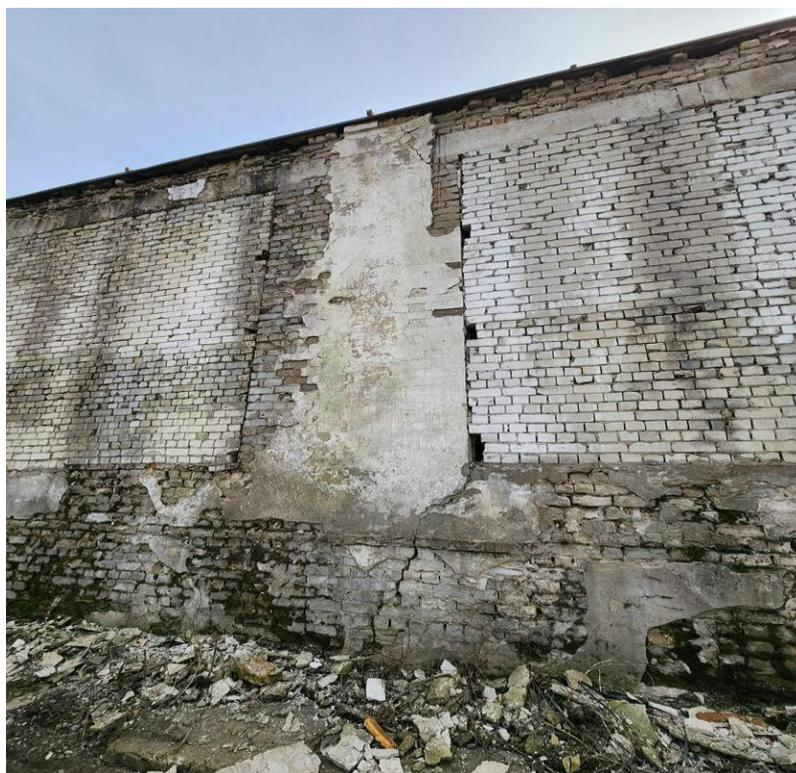
**Рис. 2. Характерный фрагмент фасада с видимыми дефектами кирпичной кладки**
