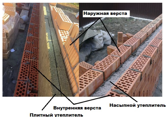
Рис. 2. Расположение утеплителя внутри стены
