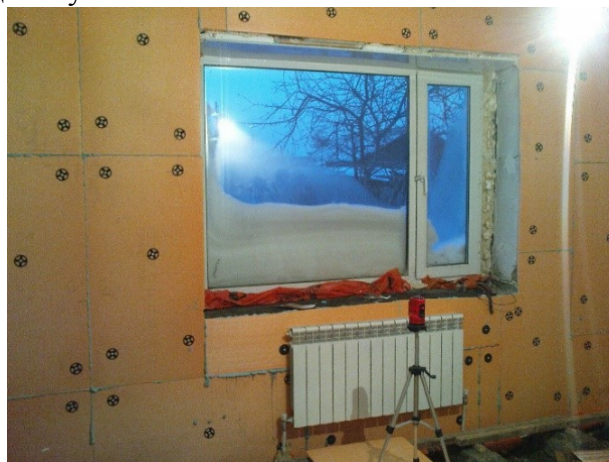
Рис. 1. Утепление стен изнутри помещения
