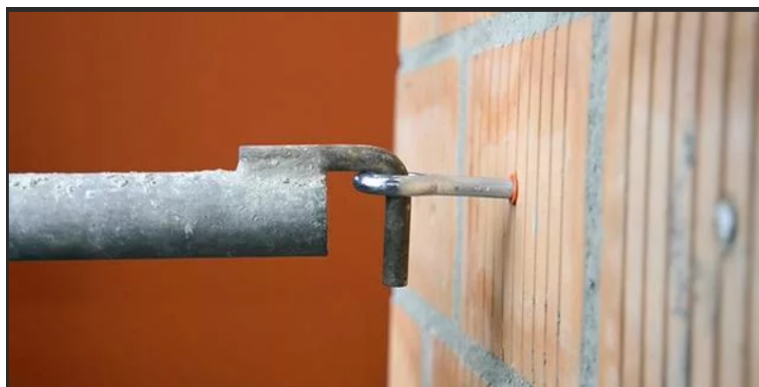
Рис. 3. Анкеровка лесов в стену
