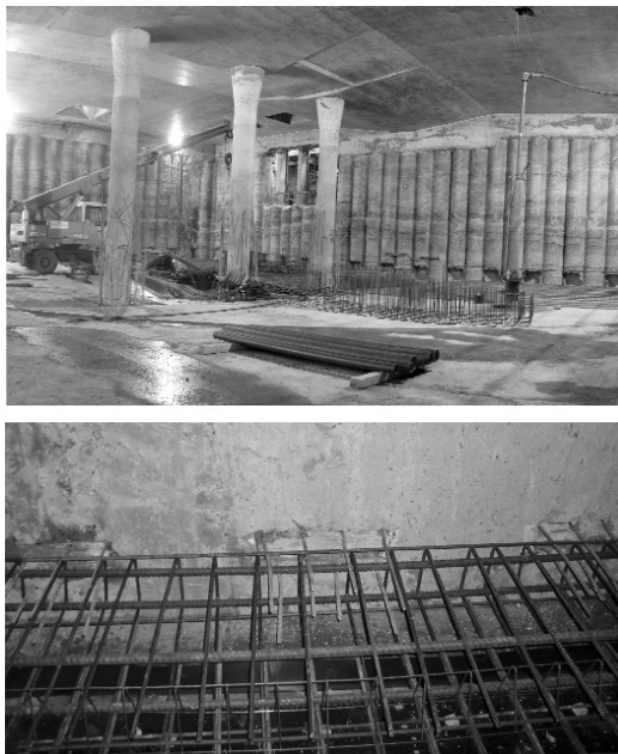
Рис. 2. Узлы соединения перекрытия и стены котлована
