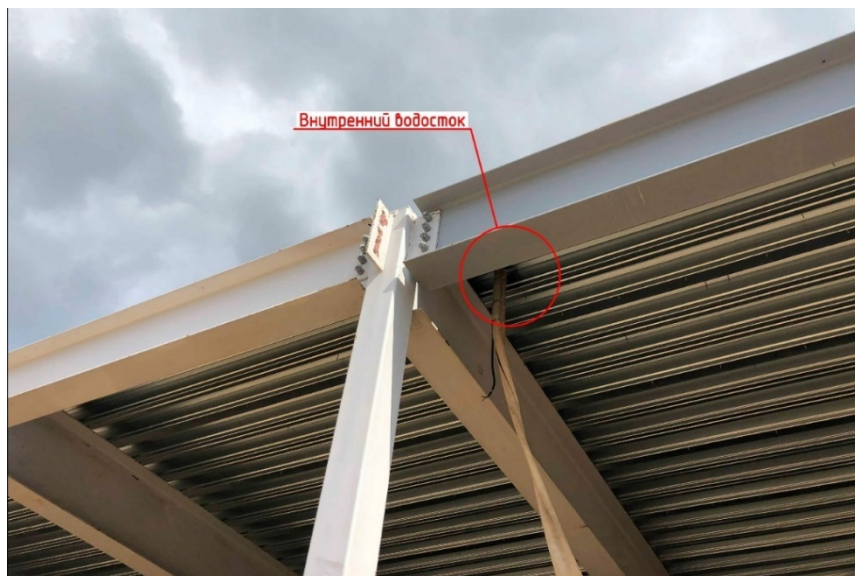
Рис. 2. Устройство внутреннего водостока (с временным отводом)
