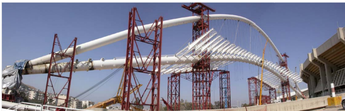
Рис. 3. Укрупнительная сборка арки на временных опорах
