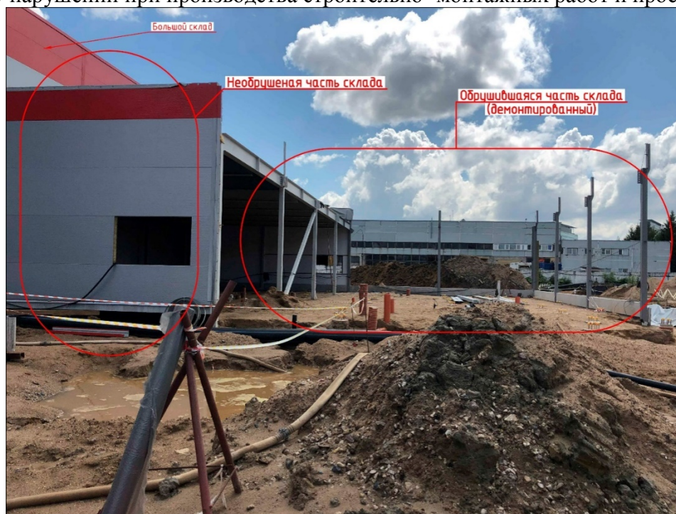
Рис. 1. Общий вид склада
