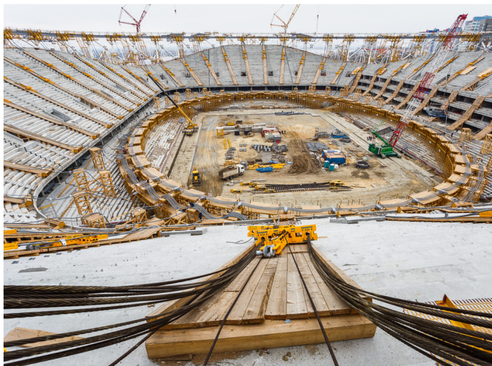
Рис. 1. Раскладка элементов вантовой конструкции на строительной площадке стадиона «Волгоград Арена»
