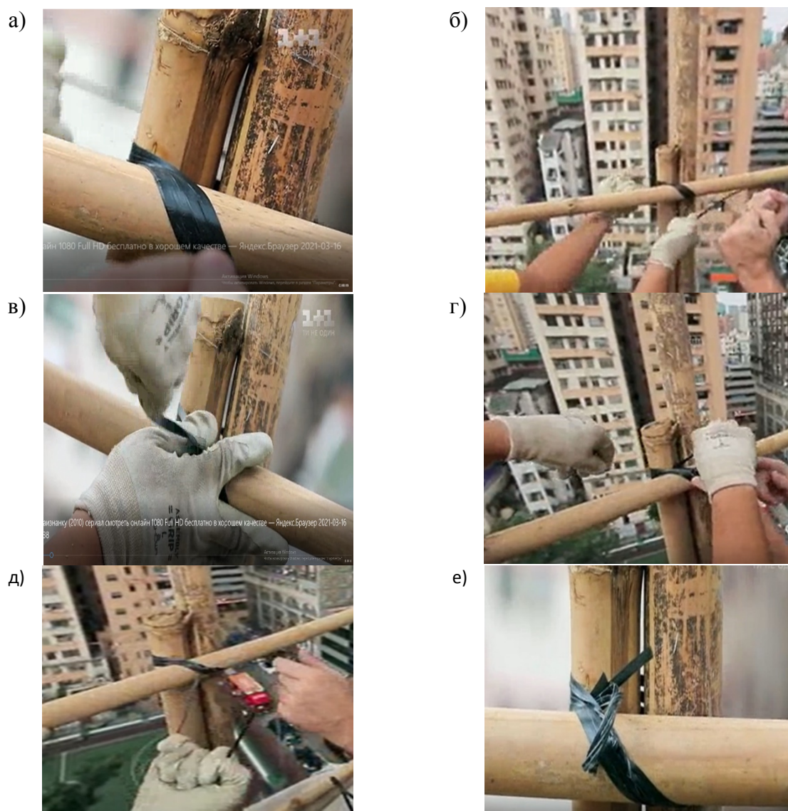
Рис. 2. Технология возведения лесов с помощью пластиковых хомутов
