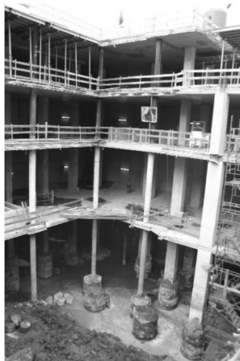
Рис. 3. Устройство временных и постоянных буровых колонн
