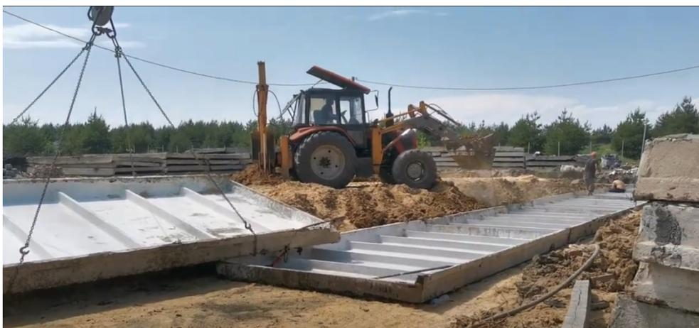
**Рис. 3. Повторное использование ж/б ребристых плит при устройстве фундаментов**
