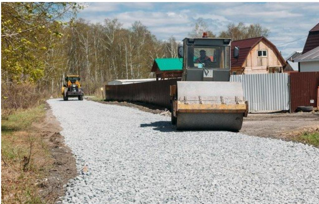
**Рис. 2. Укладка дорожного покрытия, состоящего из переработанного щебня**
