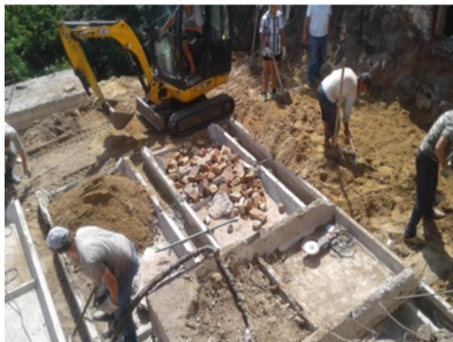
**Рис. 4. Устройство стенчатого фундамента из б/у железобетонных ребристых плит**
