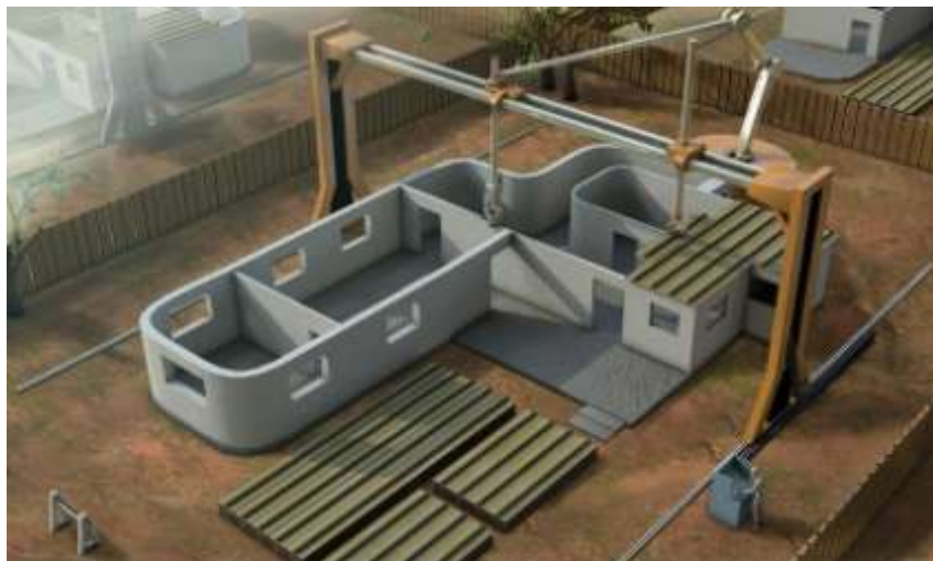
Рис. 2. 3D-печать здания [2]
