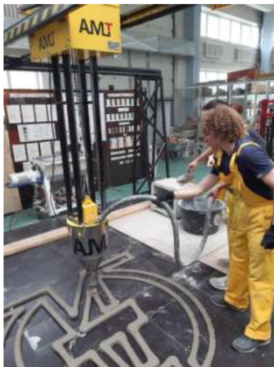
Рис. 6. Загрузки готовой смеси в бункер строительного принтера [6]
