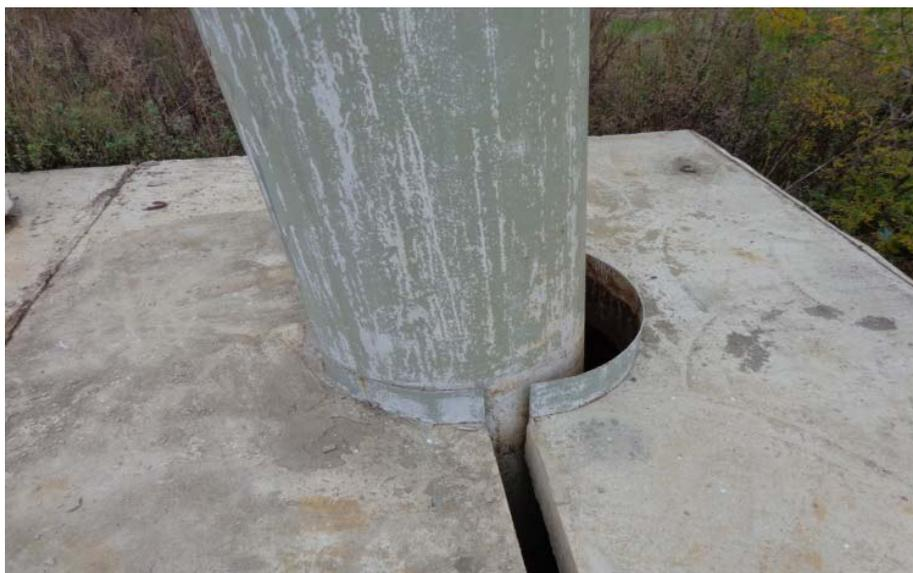
**Рис. 3.** Деформация железобетонной камеры
