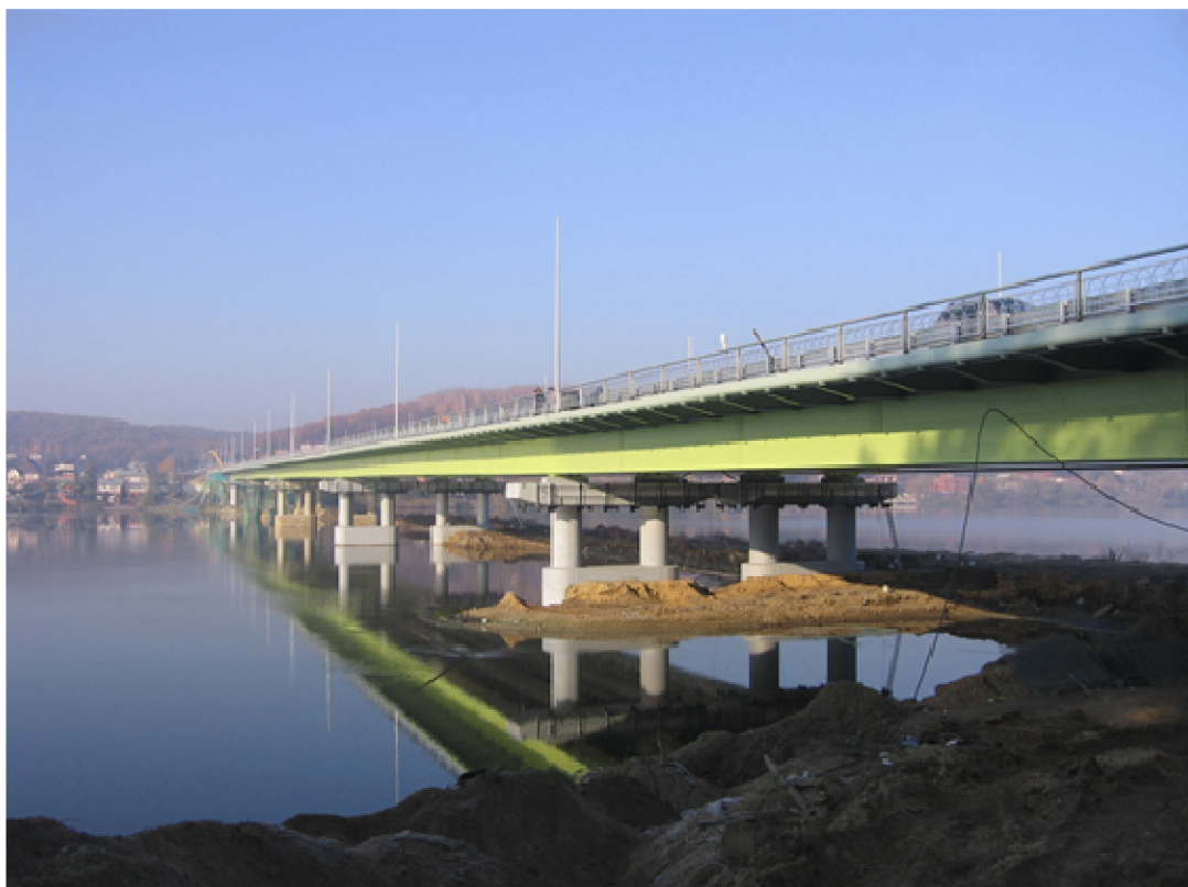
Рис. 3. Общий вид мостового перехода через Белгородское водохранилище
