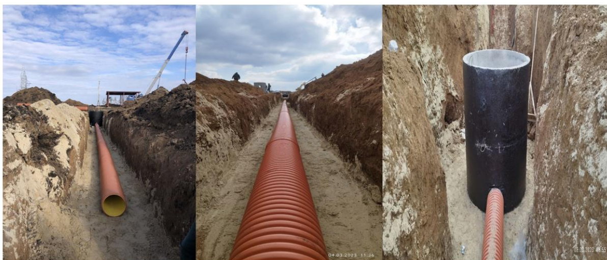
Рис. 5. Прокладка ливневой канализации
