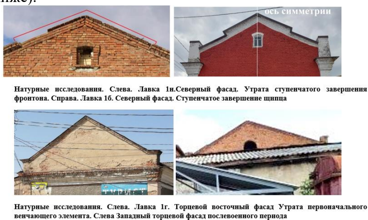
Рис. 9. Анализ формирования и декоративно-пластического оформления фронтонов в завершении торцевых фасадов лавок 1б. 1н и 1г. Фото авторов.
