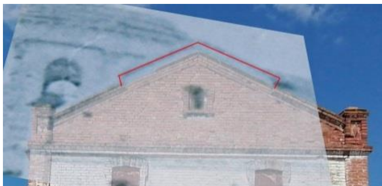
Рис. 10. Исследование формы и декоративно-пластического завершения оформления торцевого фасада лавки 1н. Фото авторов.
