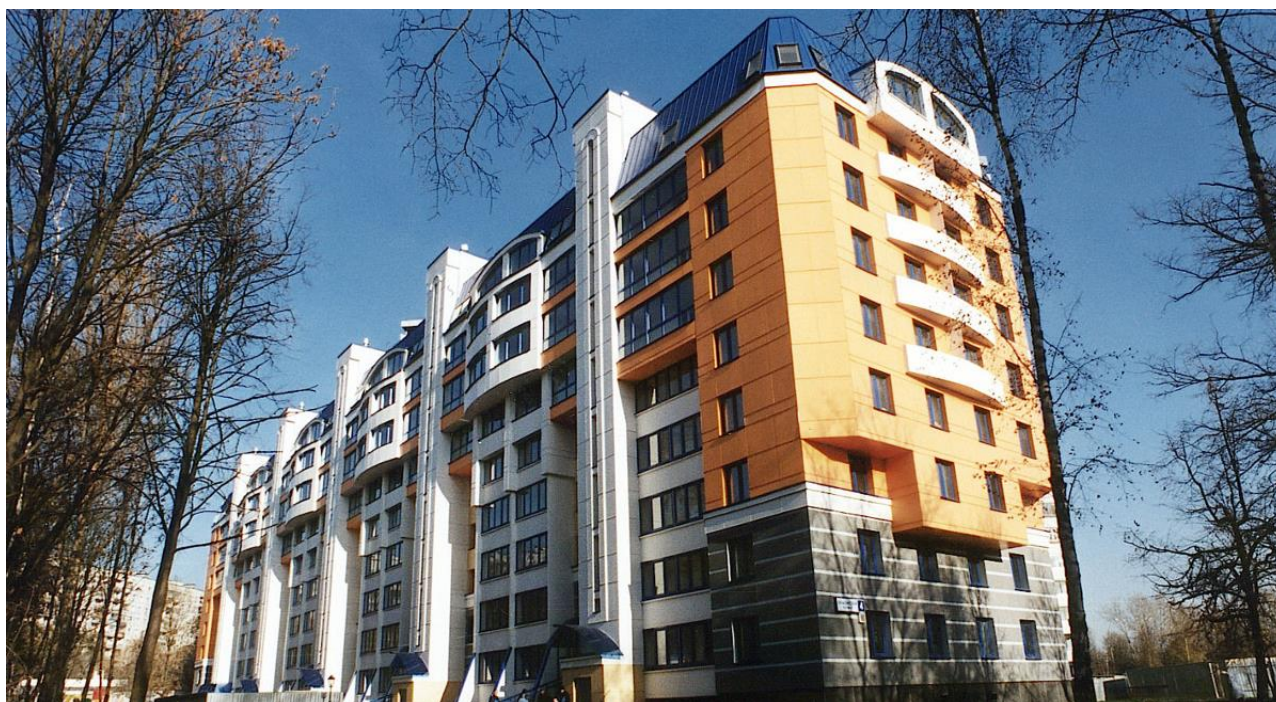
Рис. 4. Проект реконструкции жилого дома архитектора Алексея Кротова в районе Северное Тушино (2002) Источник фото: https://pikabu.ru/story/umnaya_rekonstruktsiya_pyatiyetazhek_ili_kogda_rekonstruiruesh_khrushchovku_dlya_sebya_4988979
