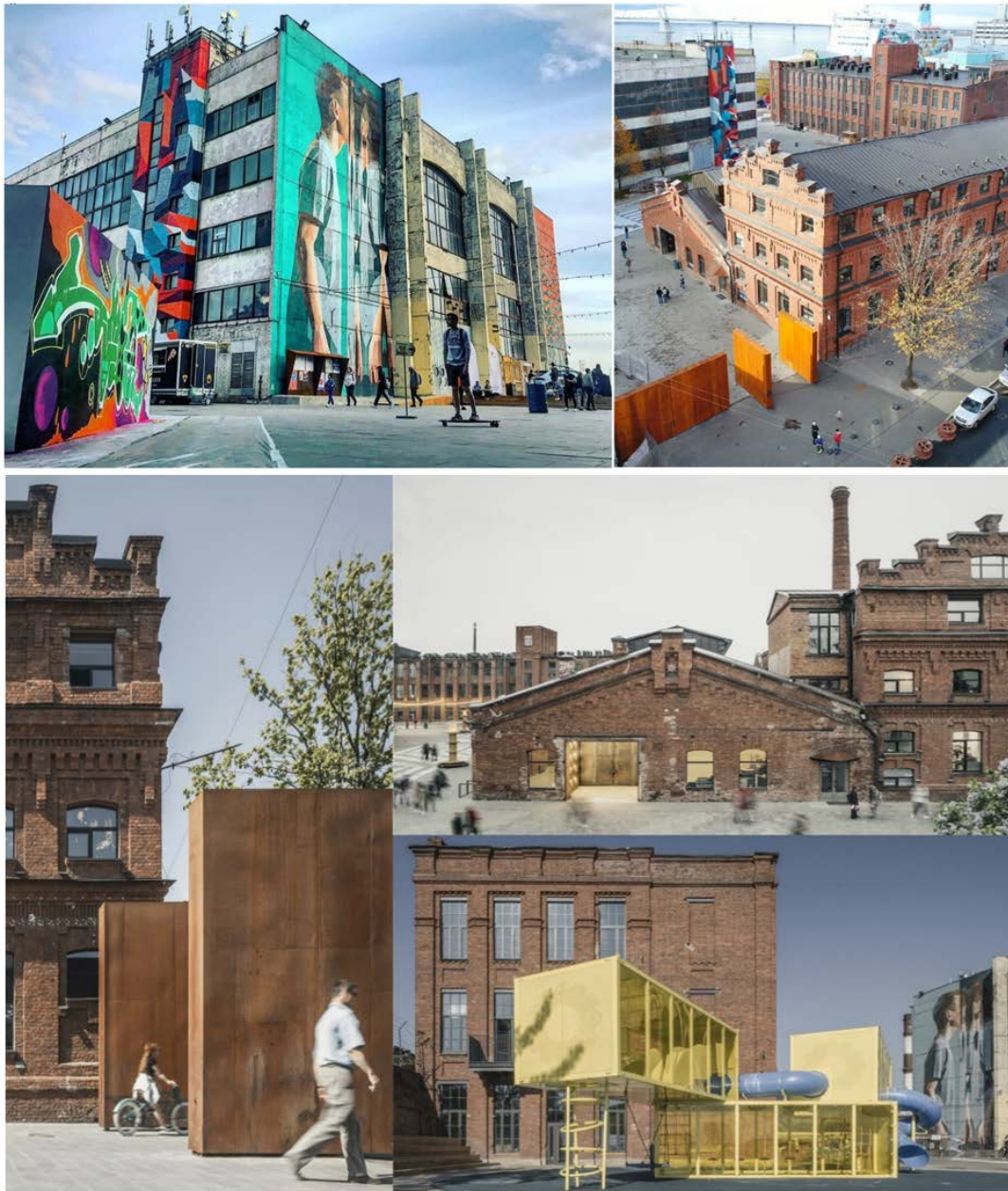
Рис. 4. «Севкабель Порт» в Санкт-Петербурге, 2020 г. [9]
