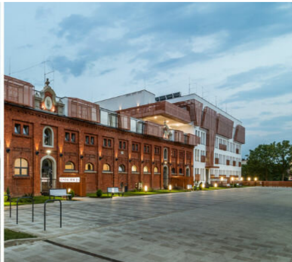
Рис. 2. Два корпуса бывшей сельскохозяйственной фермы после реконструкции в г. Лешно. Польша [10].
