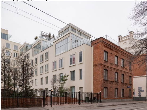
Рис. 7. Жилой дом по проекту А. Гинсбурга, г. Москва, ул. Гиляровского, д. 55 [18].
