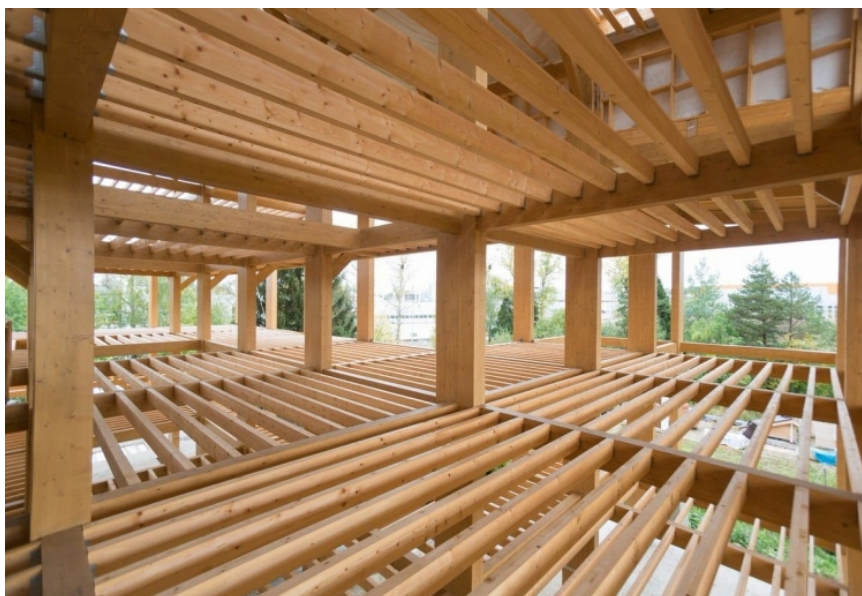
Рис. 8. Конструкции GOOD WOOD Plaza, Зеленоград
