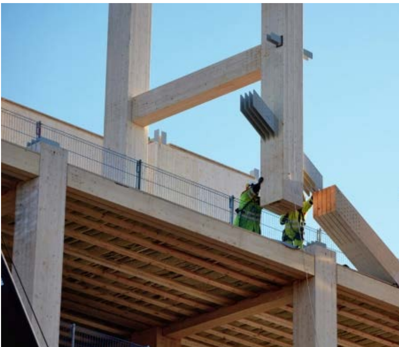
Рис. 4. Конструктивные элементы Mjosa Tower, Mjosa Норвегия, Брумунддал Источник: Mjøstårnet The Tower of Lake Mjøsa of Lake Mjøsa
