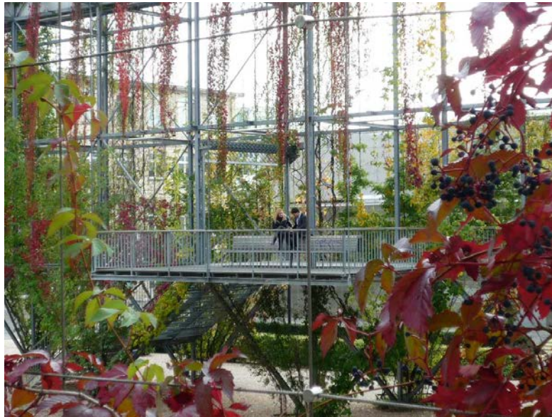
Рис. 2. Конструкции металлического каркаса. Парк MFO районе Neu Oerlikon в Цюрихе
