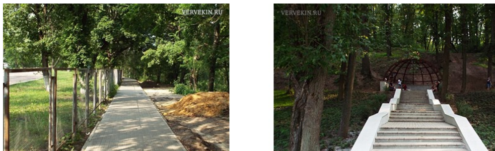
Рис. 4. Пешеходные дороги парка Динамо, не оборудованные перилами и пандусами
