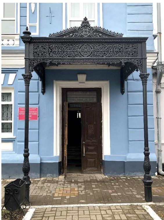
**Рис. 10.** Литой чугунный навес над главным входом в здание особняка.
