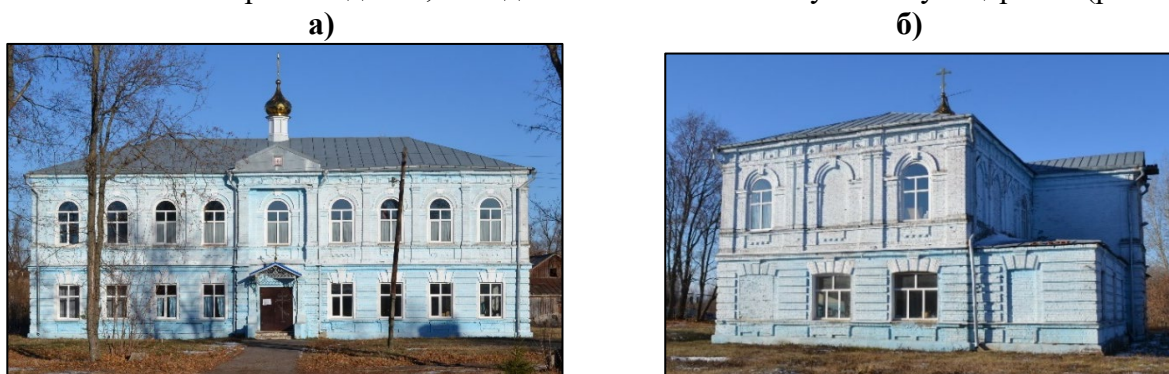
Рис. 2. а) Фото главного фасада церкви-школы с южной стороны. Ноябрь 2020г. б) Фото общего вида церкви-школы с северо-восточной стороны. Ноябрь 2020г.
