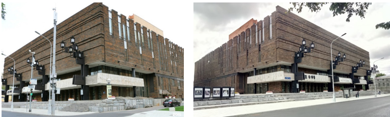
Рис. 8. Новое здание МХАТ им. Горького в Москве, Россия. 1972 г. Арх. В. Кубасов [31].
