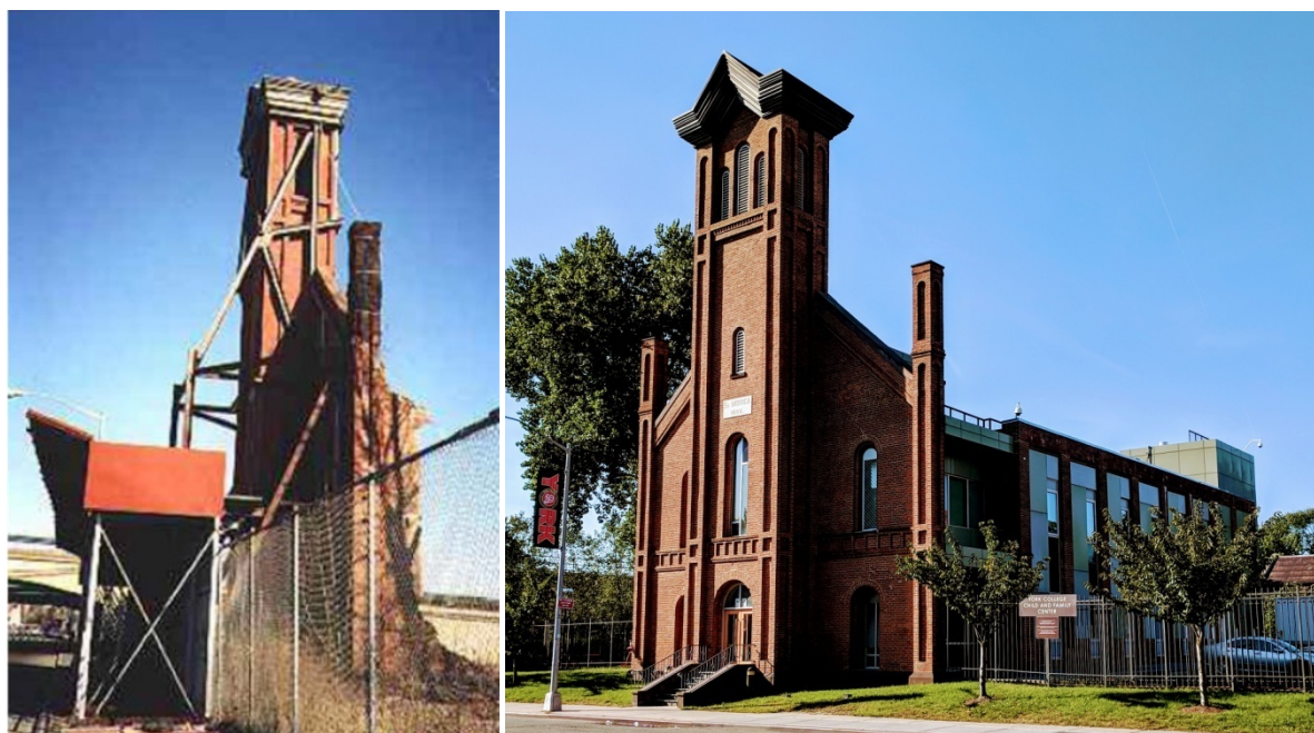
Рис. 4. Здание Римско-католической церкви Святой Моники. Ямайка. До и после реконструкции. Источник фото: https://upload.wikimedia.org/wikipedia/commons/d/db/St.Monica%27s_Church_%28Queens%29_20180930_ded.1856_01.jpg
