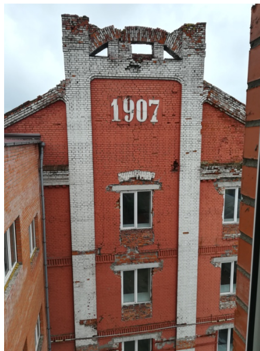
Рис. 8, 9. Наблюдается выпадение кирпичей, деструкция кирпичной кладки, трещины.
