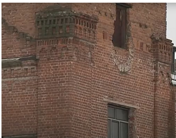
Рис. 4. Биопоражение кирпичной кладки, частичное выпадение кирпича, трещины.
