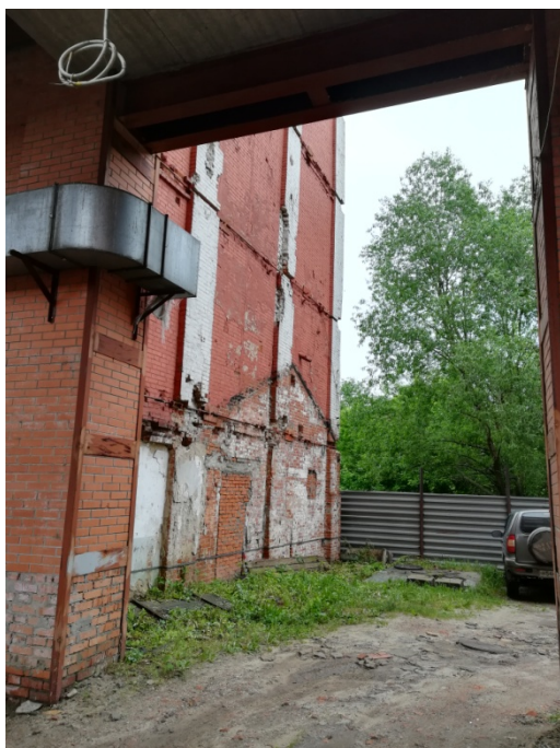
Рис. 8, 9. Наблюдается выпадение кирпичей, деструкция кирпичной кладки, трещины.
