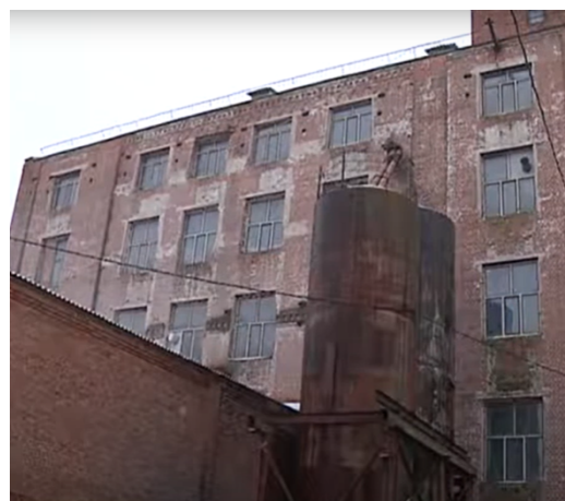
Рис. 4. Биопоражение кирпичной кладки, частичное выпадение кирпича, трещины.
