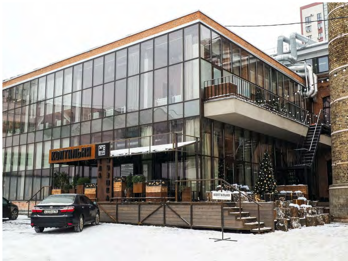
Рис. 19. Ресторан «Коптильня», г. Воронеж ул. Кольцовская, 24к
