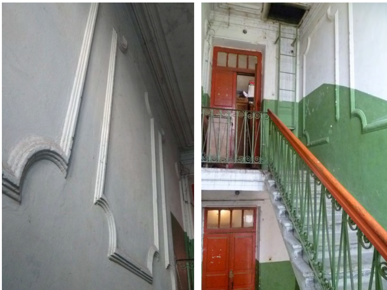
Рис. 7. Интерьер лестничной клетки.
