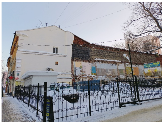
Рис. 1. Внутридворовое пространство, ул. Студенческая, д.14. Фото 2022 г.
