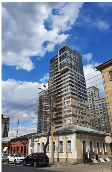
Рис. 3. Канал ул. Никитинская, вид с юго-запада на северо-восток, фото 2022 г.
