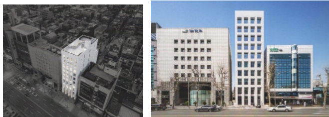
Рис. 2. Штаб-квартира мебельной фирмы NEFS . Архитектор: Тэсун Хонг. Самсунг-донг, г. Сеул, Республика Корея, 2019-2020 гг. [19]
