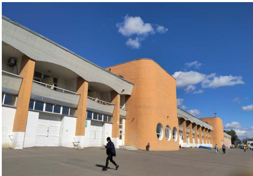
Рис. 3. Сооружения на Гребном канале (автор фото: Реуцкая Т.А. ).
