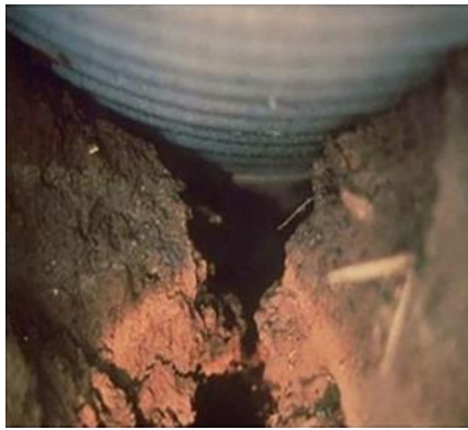
Рисунок 7 – Пример размыва основания Рисунок 8 – Схема нагрузки с учетом размыва
