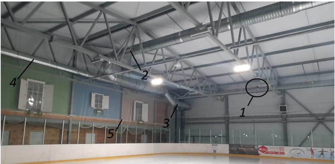
Рисунок 2.30 – Расположение характерных элементов крытого катка при тепловизионной съемке (вид 3): 1 – приточные сопловые воздухораспределители; 2 – воздухозаборные решетки; 3 – вытяжной воздуховод; 4 – приточный воздуховод; 5 – трубопроводы системы водо-воздушного отопления
