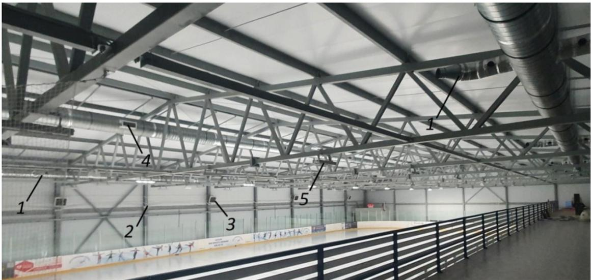
Рисунок 2.28 – 1 Расположение характерных элементов крытого катка при тепловизионной съемке (вид 2): 1 – приточные сопловые воздухораспределители; 2 – трубопроводы системы водо-воздушного отопления; 3 – отопительные агрегаты; 4 – вытяжной воздуховод; 5 – светильники
