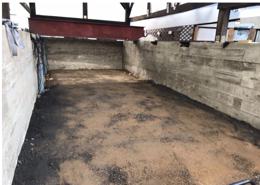
Рисунок 38 - Слой основания из холодной органоминеральной смеси после уплотнения
