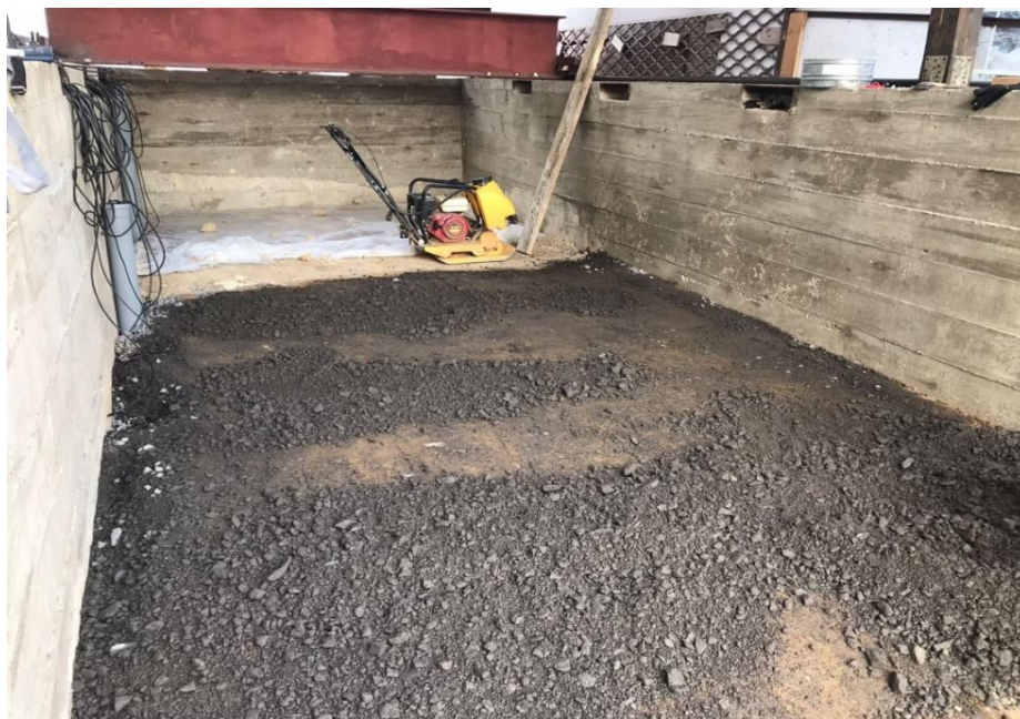
Рисунок 37 - Устройство слоя основания из холодной органоминеральной смеси
