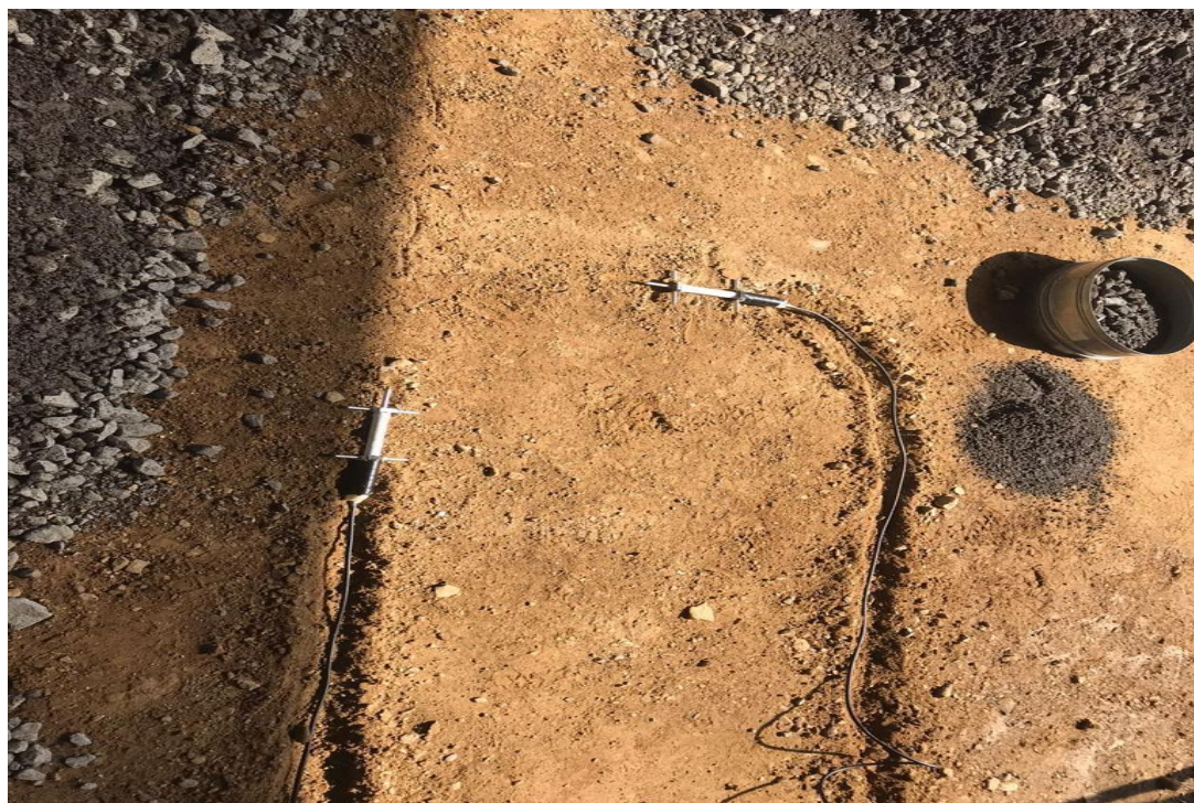
Рисунок 33 - Монтаж датчиков деформаций на поверхности слоя из ЩПС
