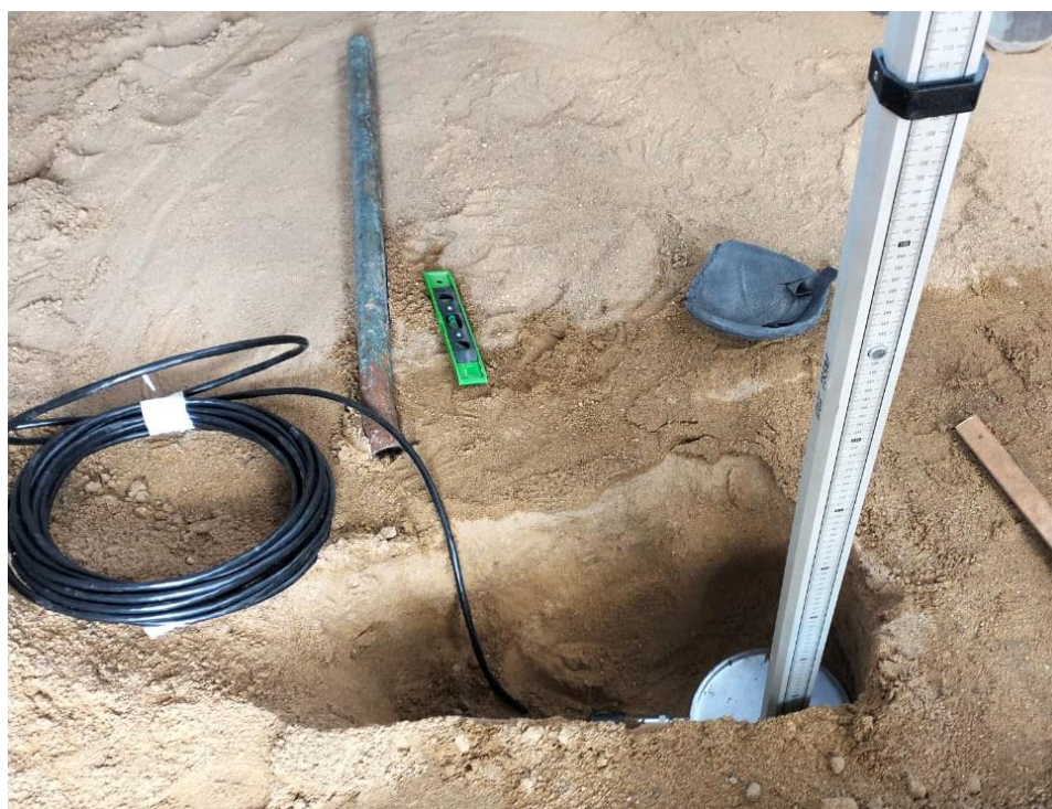
Рисунок 27 - Монтаж датчиков напряжений в слой из песка
