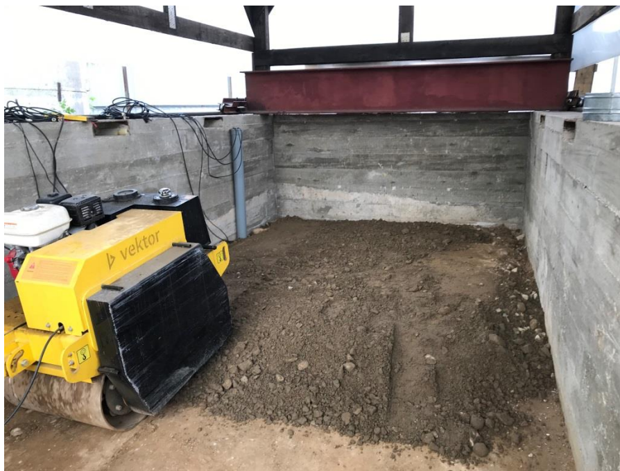
Рисунок 35 – Уплотнение слоя из ЩПС, укрепленного цементом (для конструкции 1)
