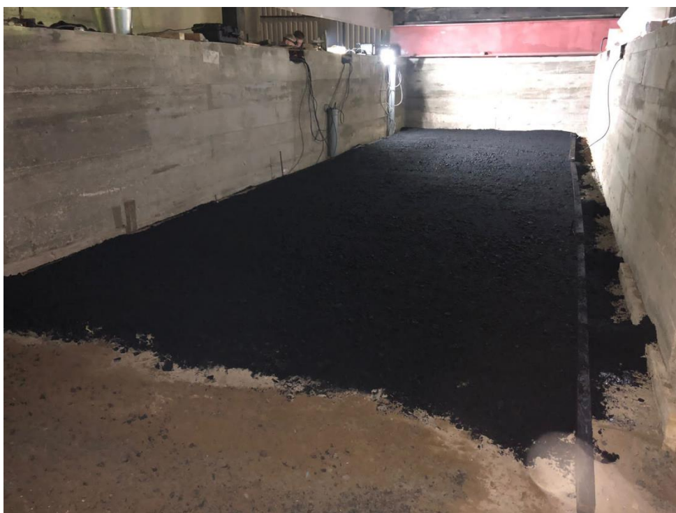
Рисунок 42 – Распределение асфальтобетонной смеси
