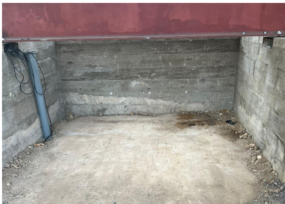
Рисунок 36 – Общий вид слоя из ЩПС, укрепленного цементом после набора прочности (для конструкции 1)
