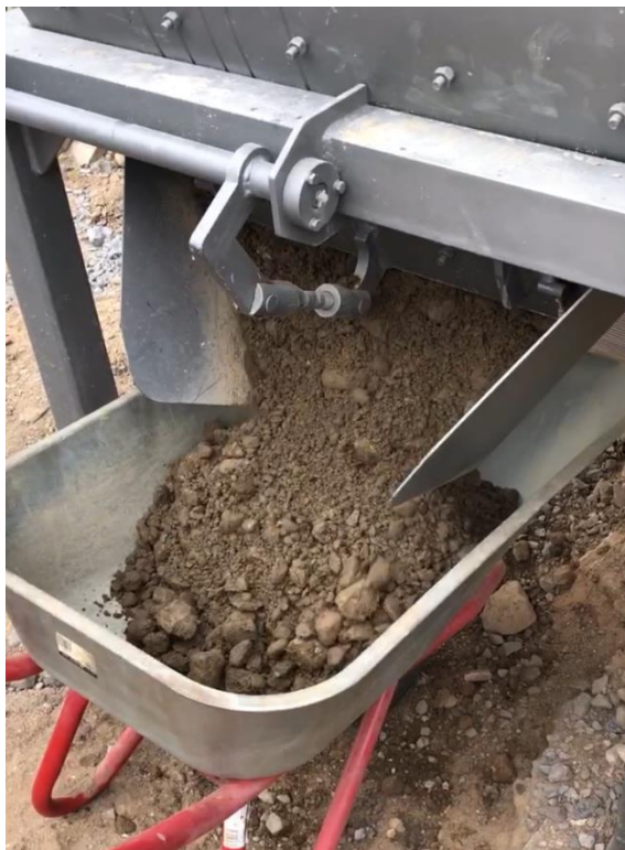
Рисунок 34 – Выгрузка ЩПС, укрепленной цементом, из смесительного барабана
