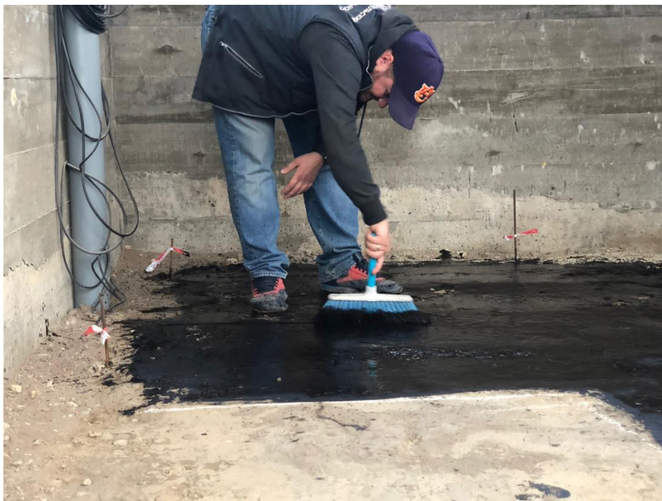
Рисунок 39 – Подгрунтовка слоя основания перед укладкой асфальтобетона
