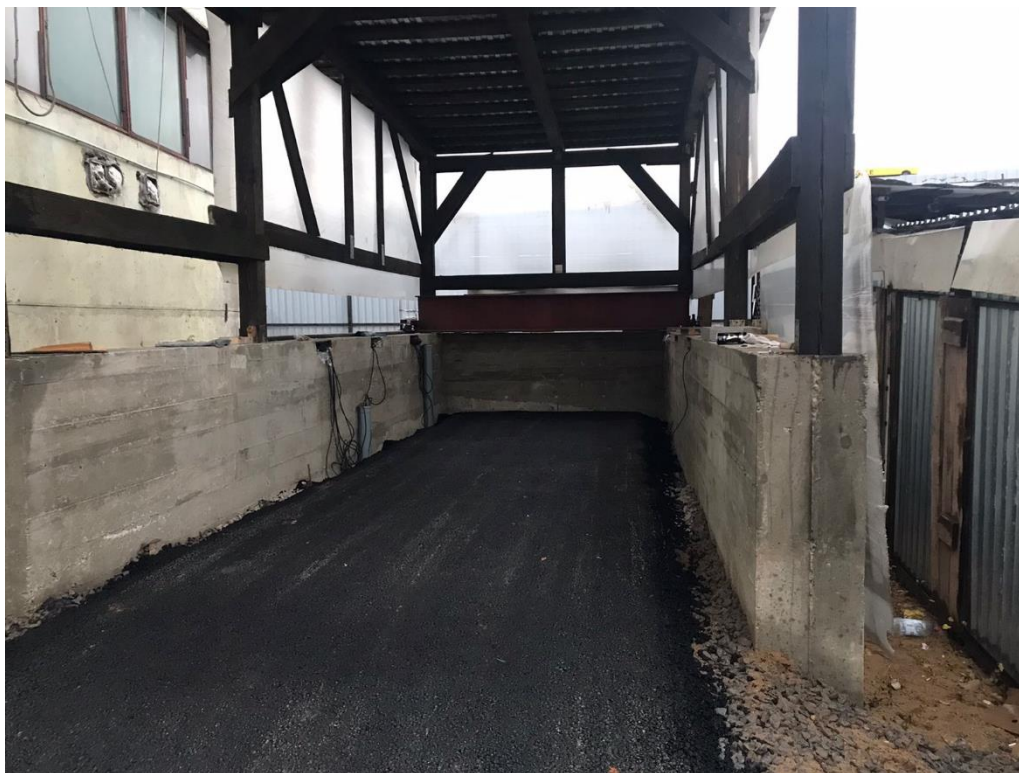
Рисунок 44 – Уплотненный слой из асфальтобетона
