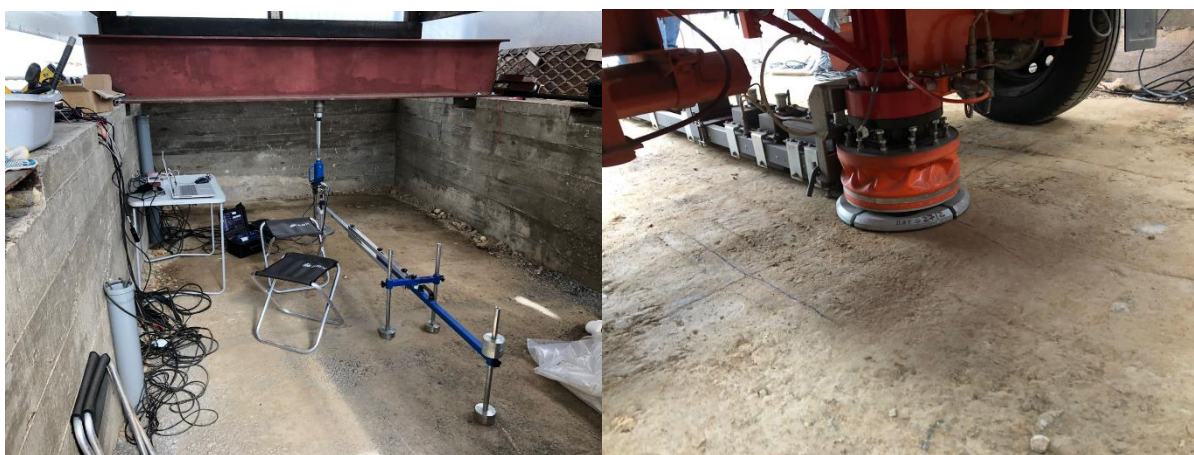
Рисунок 49 - Испытания на слое основания из укрепленных материалов
