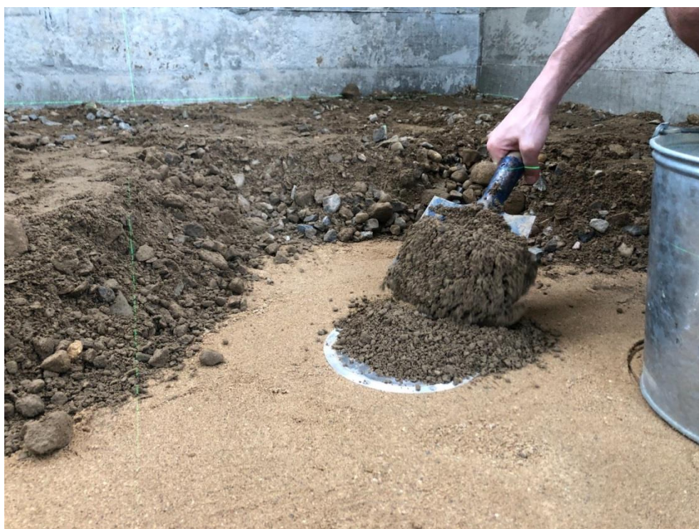
Рисунок 31— Засыпка датчика давления под слоем ЩПС
