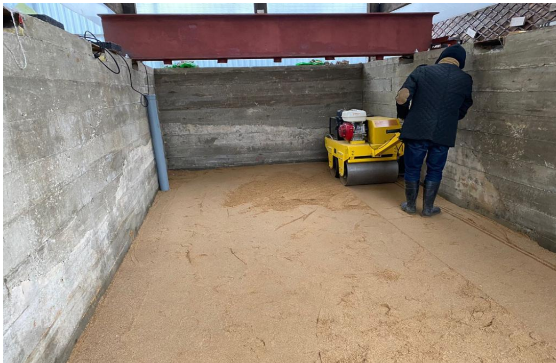
Рисунок 25 – Устройство и уплотнение слоя из песка
