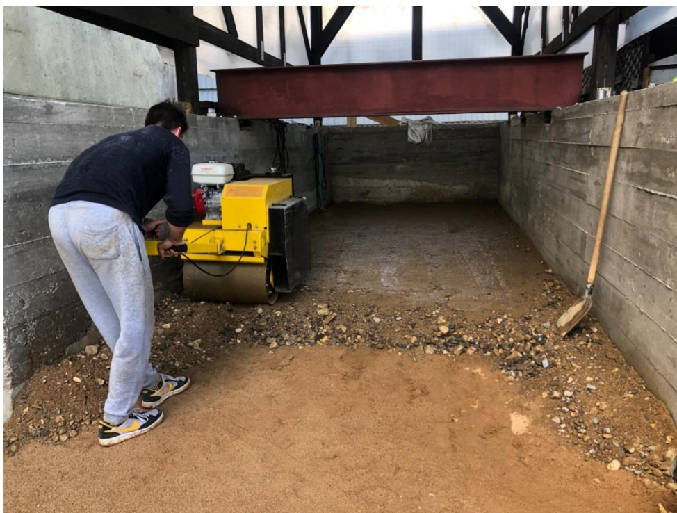
Рисунок 32 – Уплотнение конструктивного слоя из ЩПС
