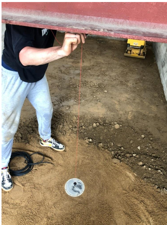
Рисунок 30— Установка датчика давления под слоем ЩПС
