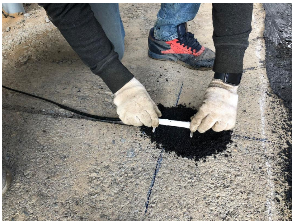
Рисунок 40 – Монтаж датчиков деформаций на поверхности слоя основания
