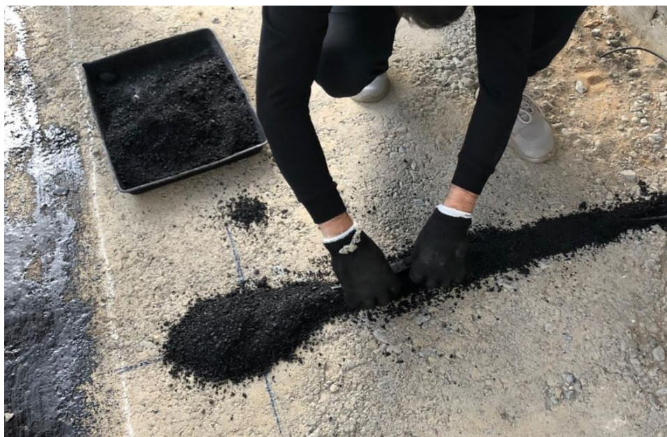
Рисунок 41 – Монтаж датчиков деформаций на поверхности слоя основания Устройство слоев асфальтобетона представлено на рисунках 42-44.
