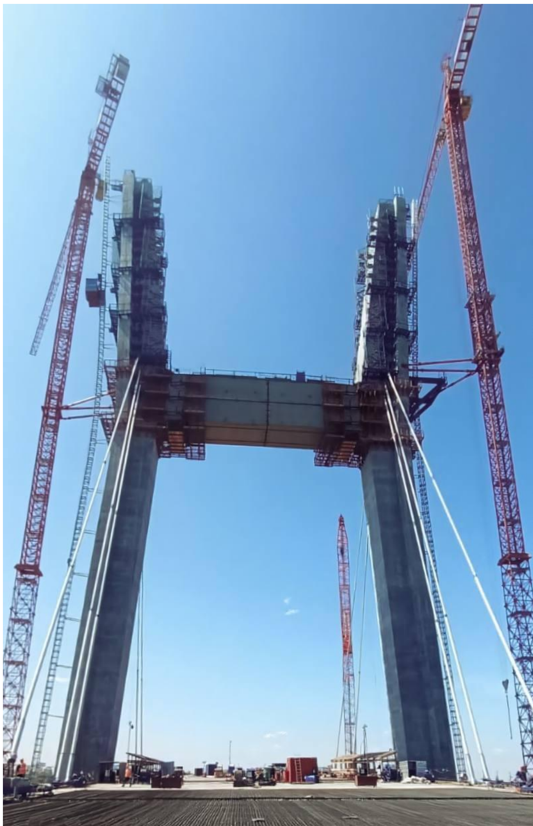
Рисунок 71 – Фотография пилона во время бетонирования
