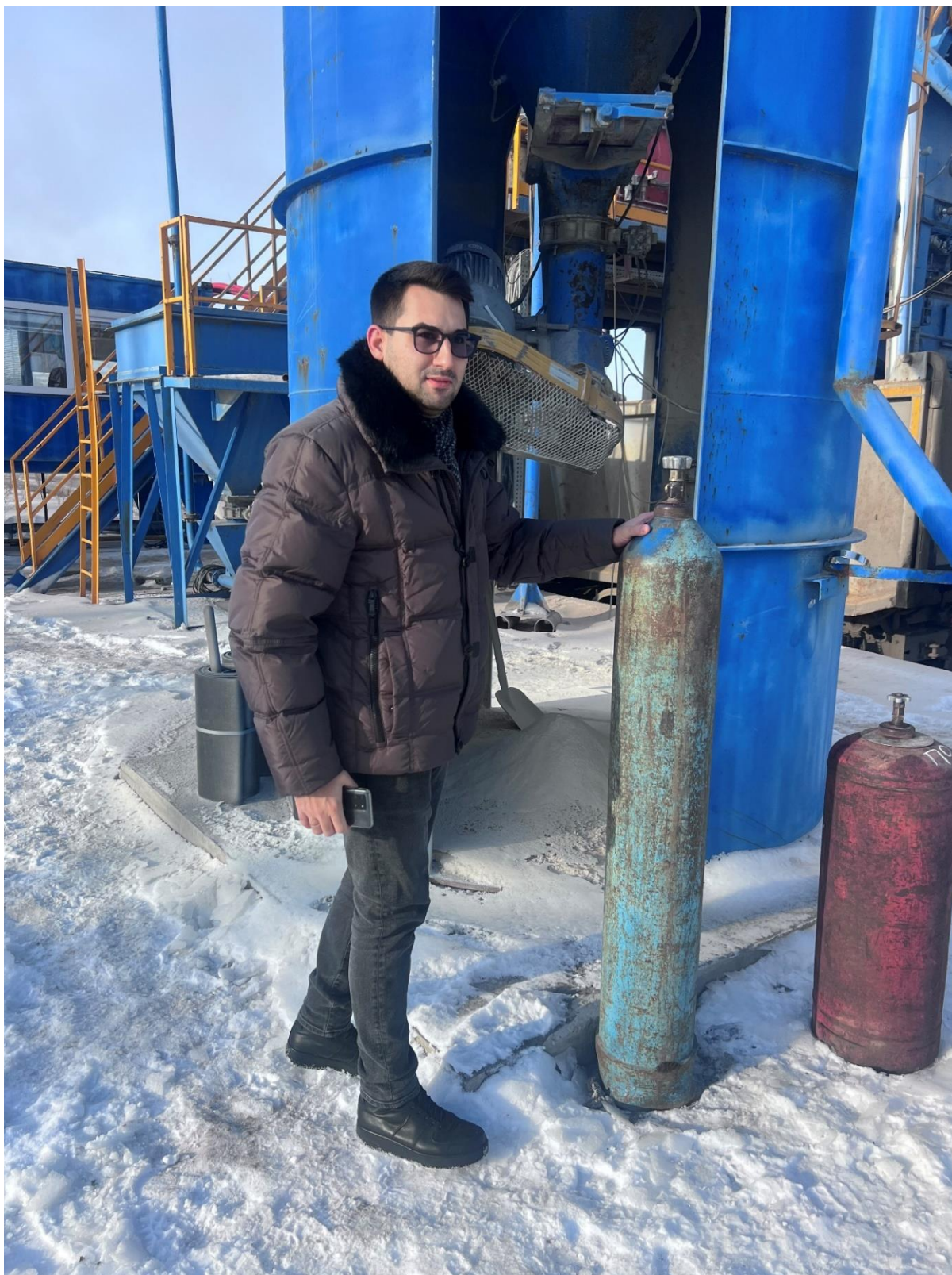
Рисунок 3.30 – Процесс монтажа баллонов с защитным газом
