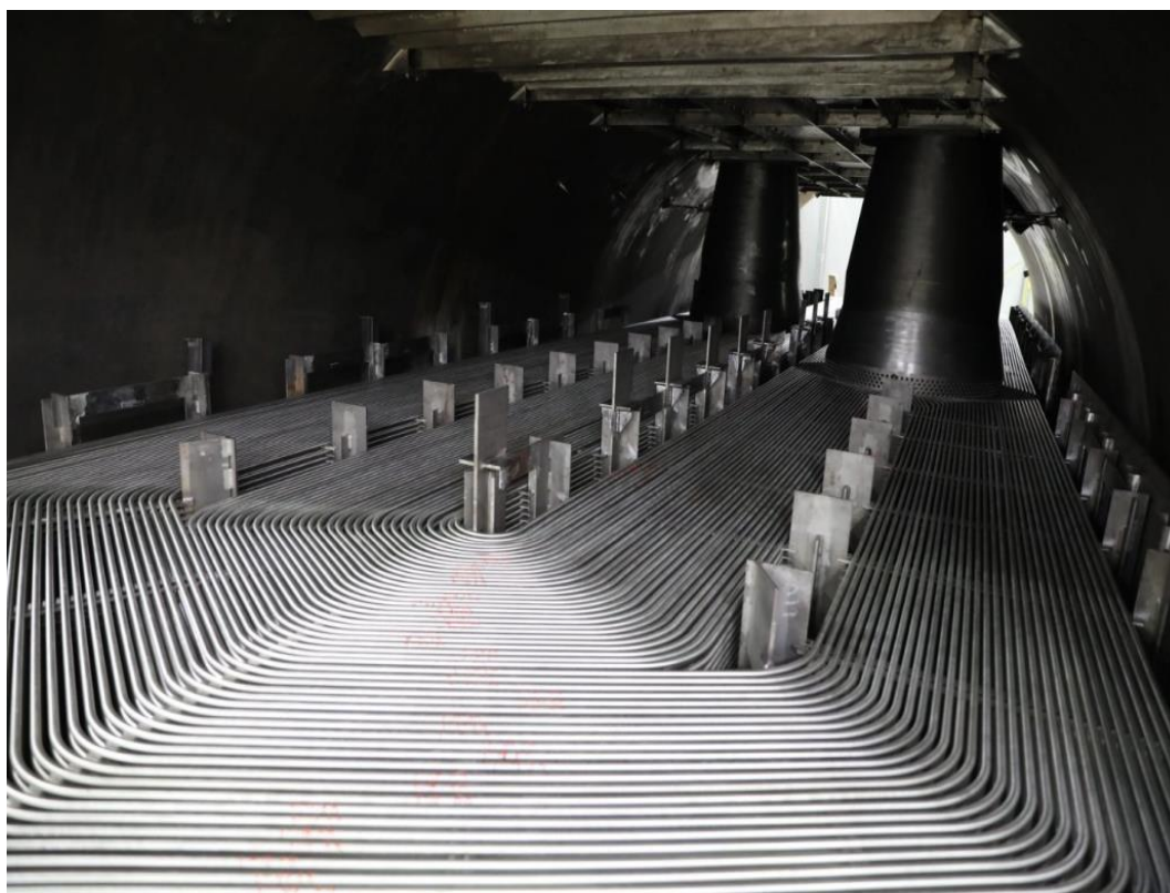
Рисунок 5.2 - Теплообменник парогенератора водо-водяного энергетического реактора с каналами для охлаждения жидкости
