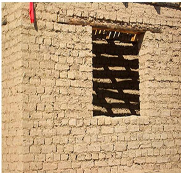
**Рис. 1.** Кладка из глиняного кирпича с глиняном раствором
