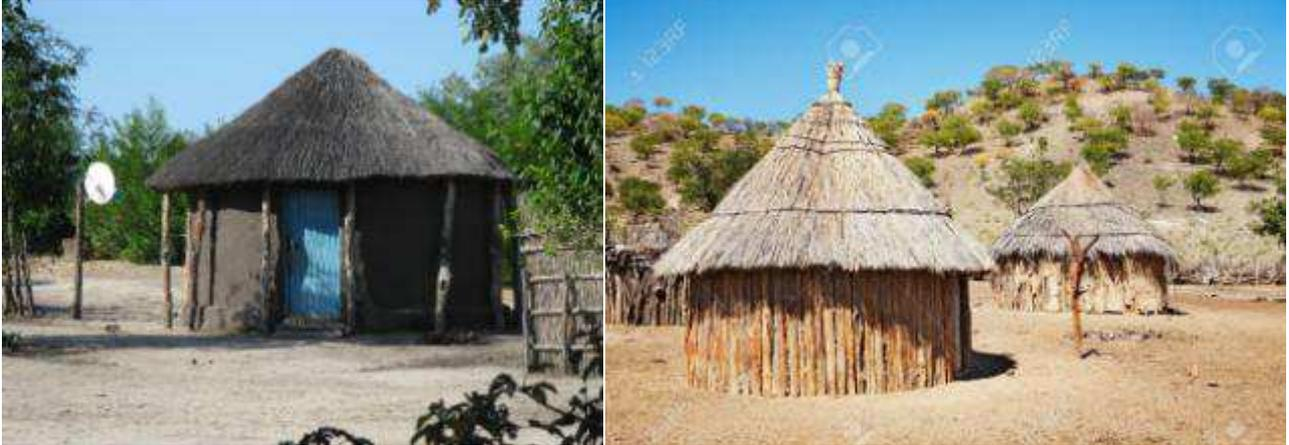
**Рис. 2.** Стены из дерева (бревна с глиняном растворе)
