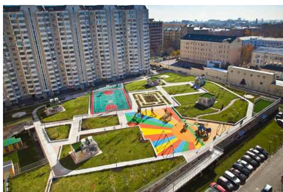
Рис. 2. Эксплуатируемая кровля парковки ЖК «Алексеево»
