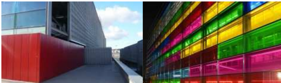
Рис. 1. Реконструкция промышленного здания в Стамбуле, Турция
