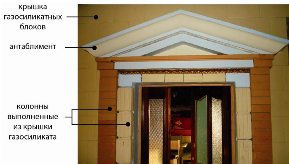
Рис. 3. Входная группа выполненная из крышки газосиликатных блоков
