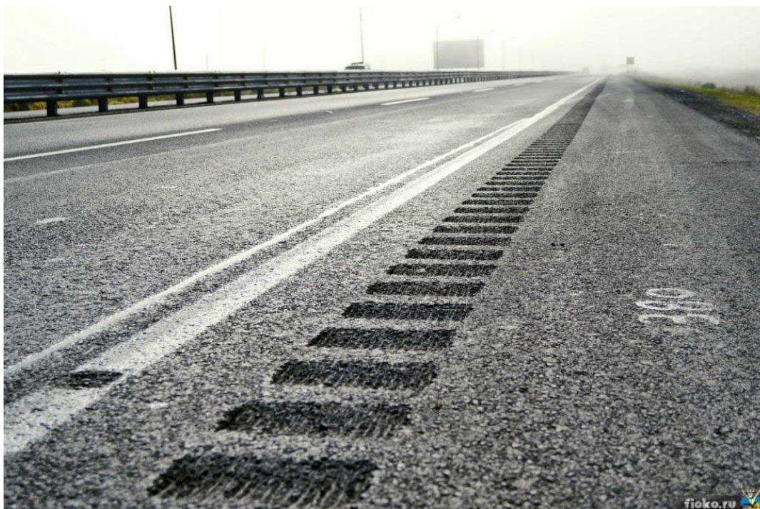
Рис. 1. Шумовая полоса, выполненная методом фрезерования асфальтного покрытия
