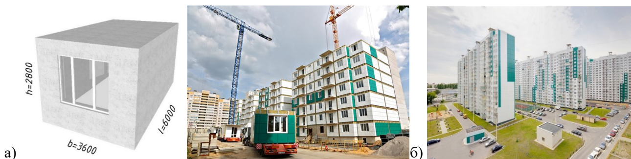
Рис. 2. Жилой комплекс на ул. Беговая, г. Воронеж: а – габариты объемного блока типа «колпак» от компании «Выбор ОБД»; б – жилой дом на этапе строительства; в – комплекс после завершения строительства.
