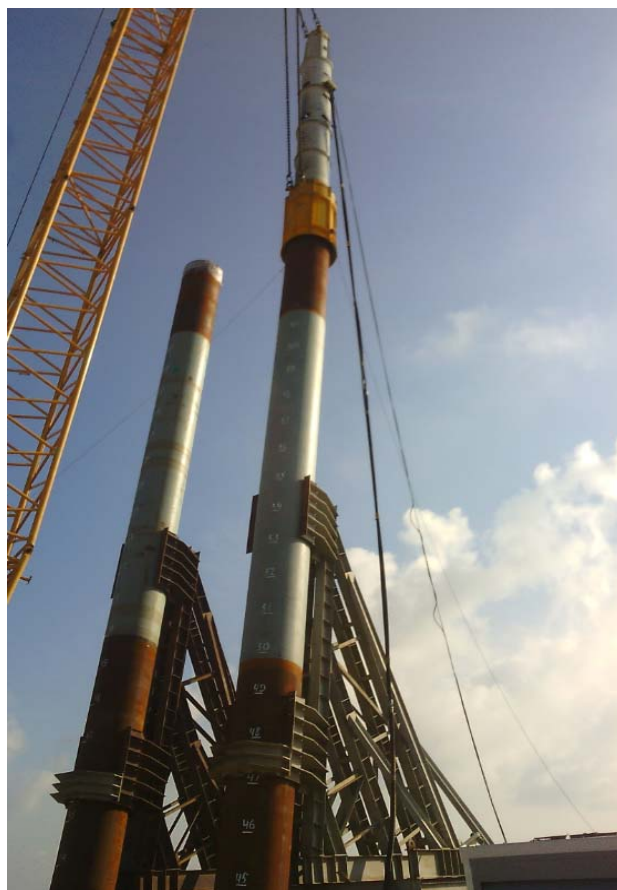
Рис. 2. Погружение стальных трубчатых свай
