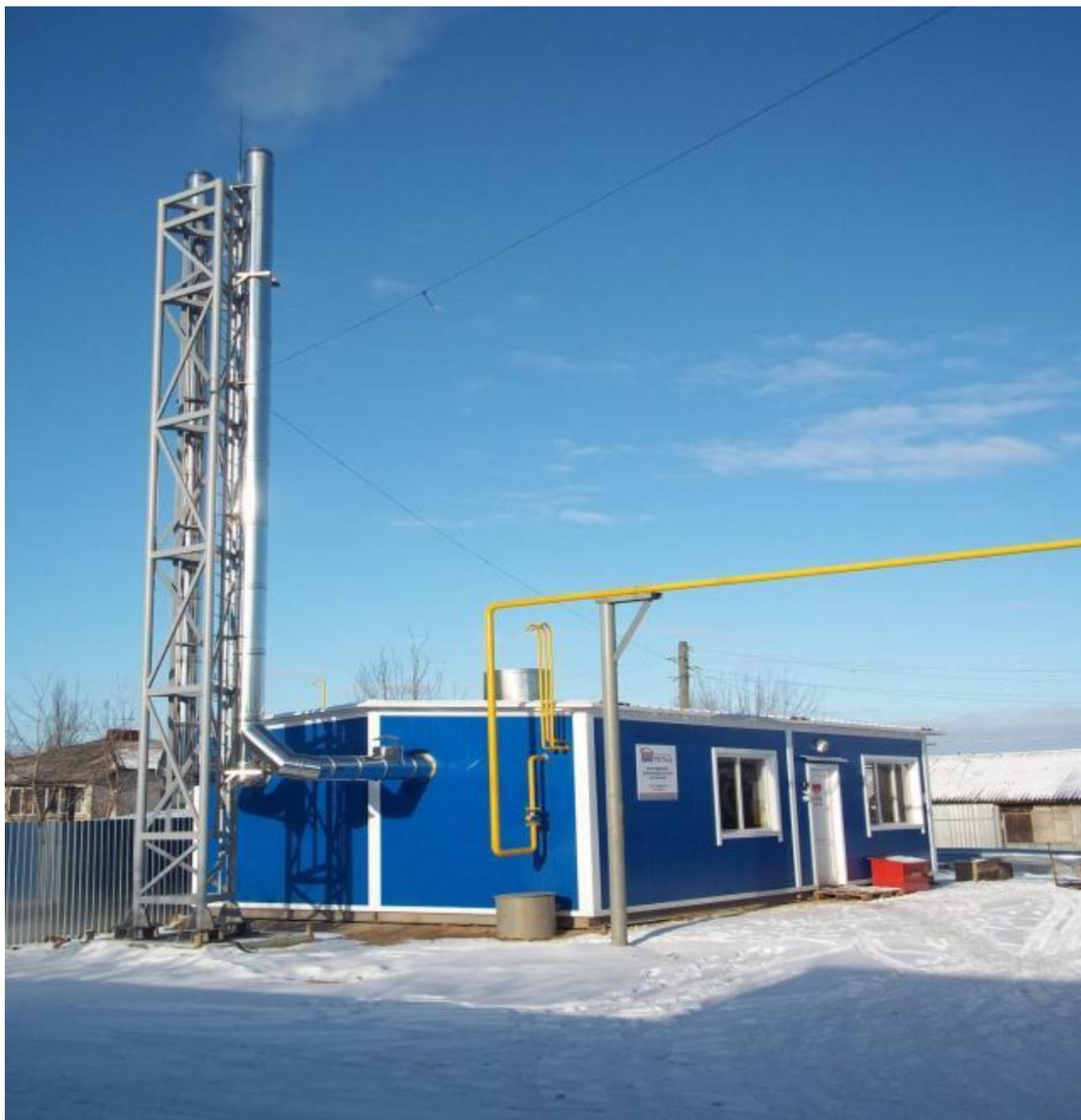
**Рис. 2.** Блочно-модульная котельная
