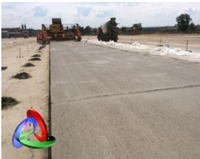
**Рис. 5.** Устройство швов и уход за бетонным покрытием
