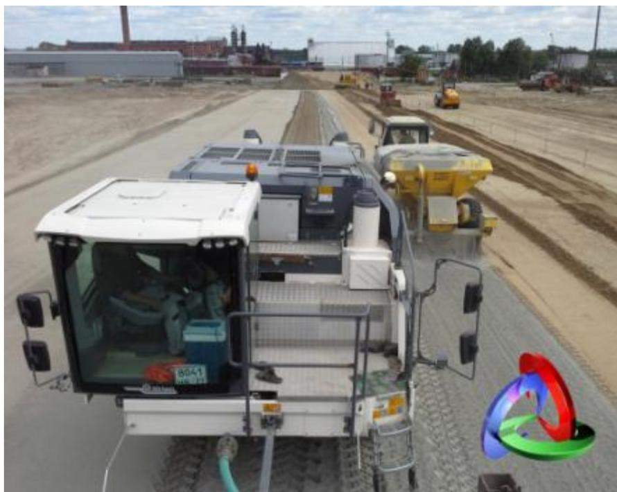
**Рис. 2.** Современный технологический комплекс, используемый на этапе стабилизации и минерализации грунта при производстве дорожно-строительных работ
