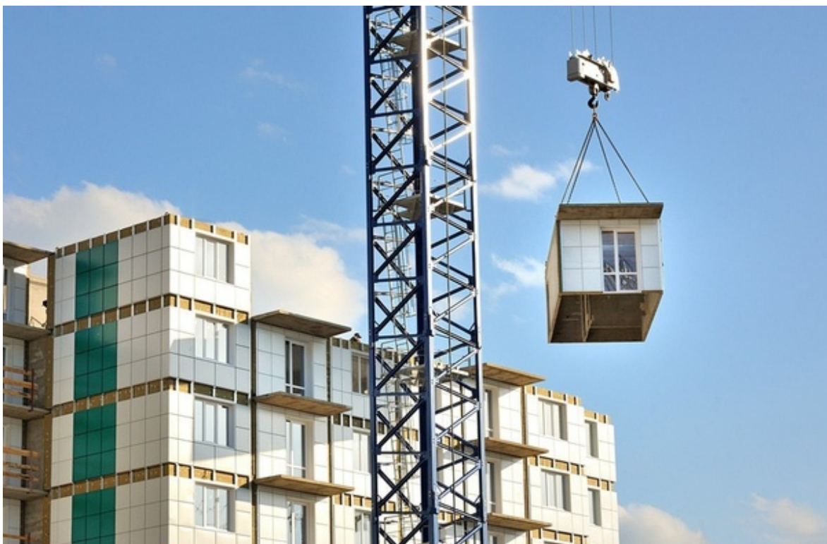
Рис.3. Монтаж объемного блока краном
