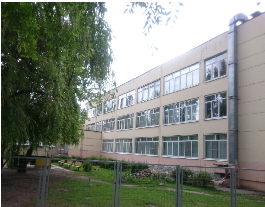
Рис. 1. Исследуемое здание школы
