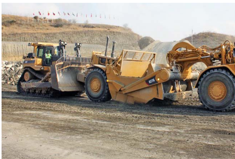
Рис. 3. Усиление отвала бульдозера для работы в качестве толкача ДЗ-121
