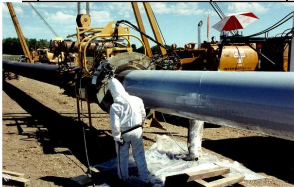
Рис. 3. Переизоляция газопровода в трассовых условиях
