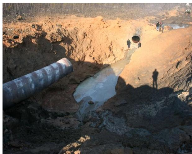
Рис. 2. Последствия аварии на магистральном газопроводе
