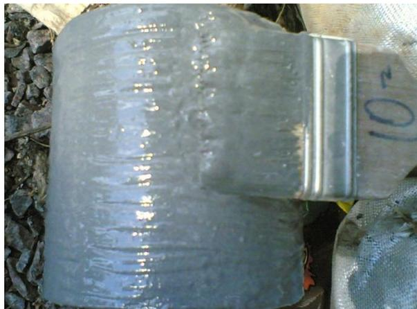
**Рис. 4.** Нанесение каучуковой мастики на стальную трубу при помощи кисти
