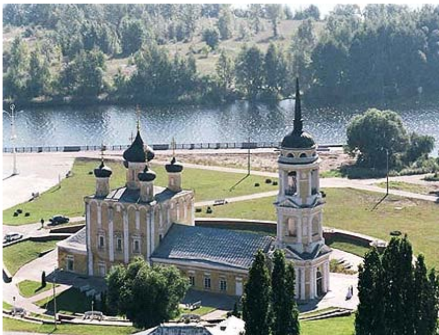
Рис. 3. Адмиралтейская (Успенская) церковь. Современный вид.
