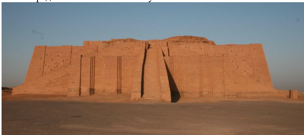
Рис. 1. Зиккурат. Использование кирпича-сырца.
