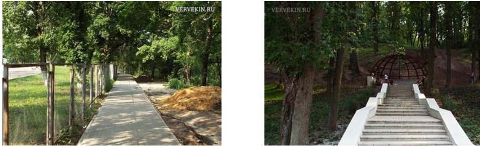
Рис. 5. Пешеходные дороги парка Динамо, не оборудованные перилами и пандусами
