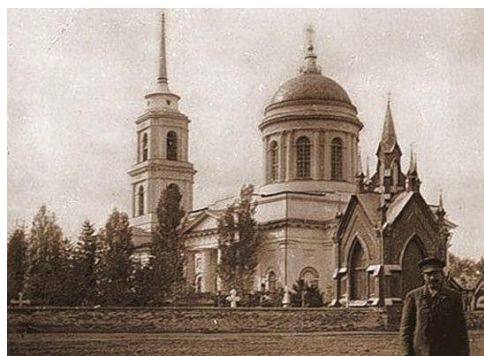
Рис. 11. Постройка 17 века - Всесвятская церковь
