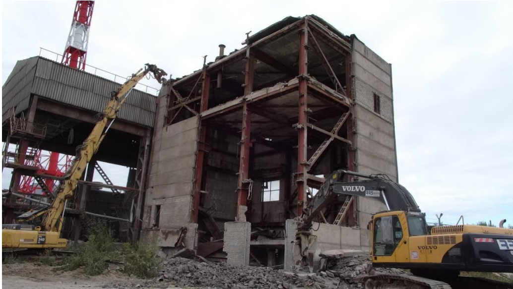
Рис. 1. Поэлементная разборка здания.
