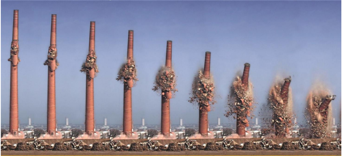
Рис. 3. Взрывной метод сноса.
