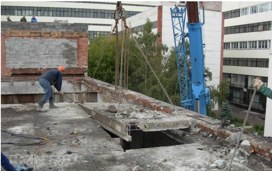
Рис. 2. Разбор плитоперекрытия здания для повторного использования.
