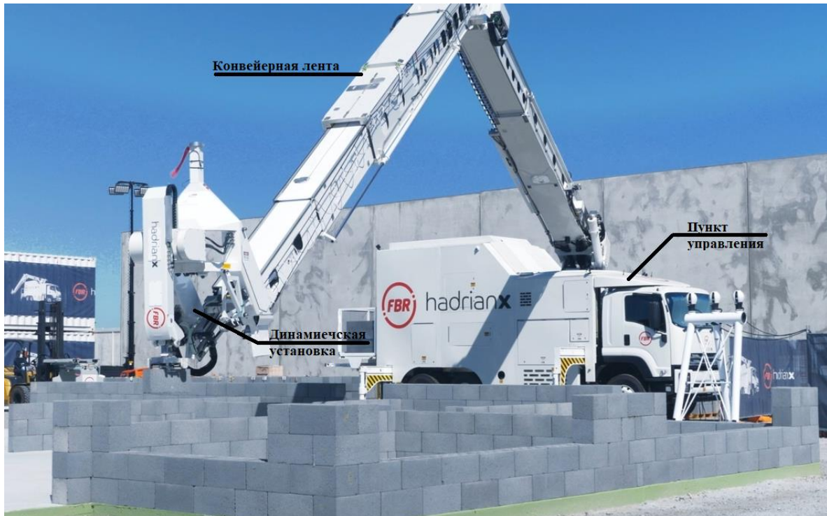
Рис. 3. Полуавтоматический робот Hadrian X (2015 год)
