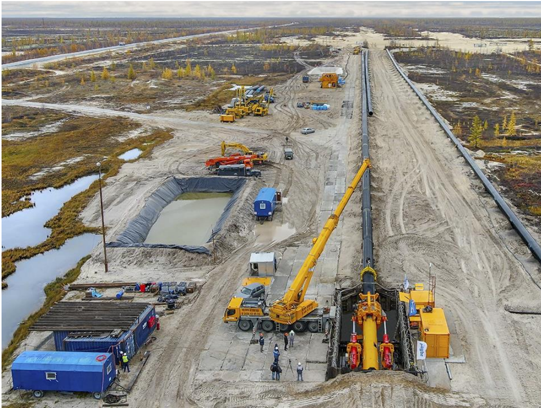
Рис. 5. Технология Direct Pipe
