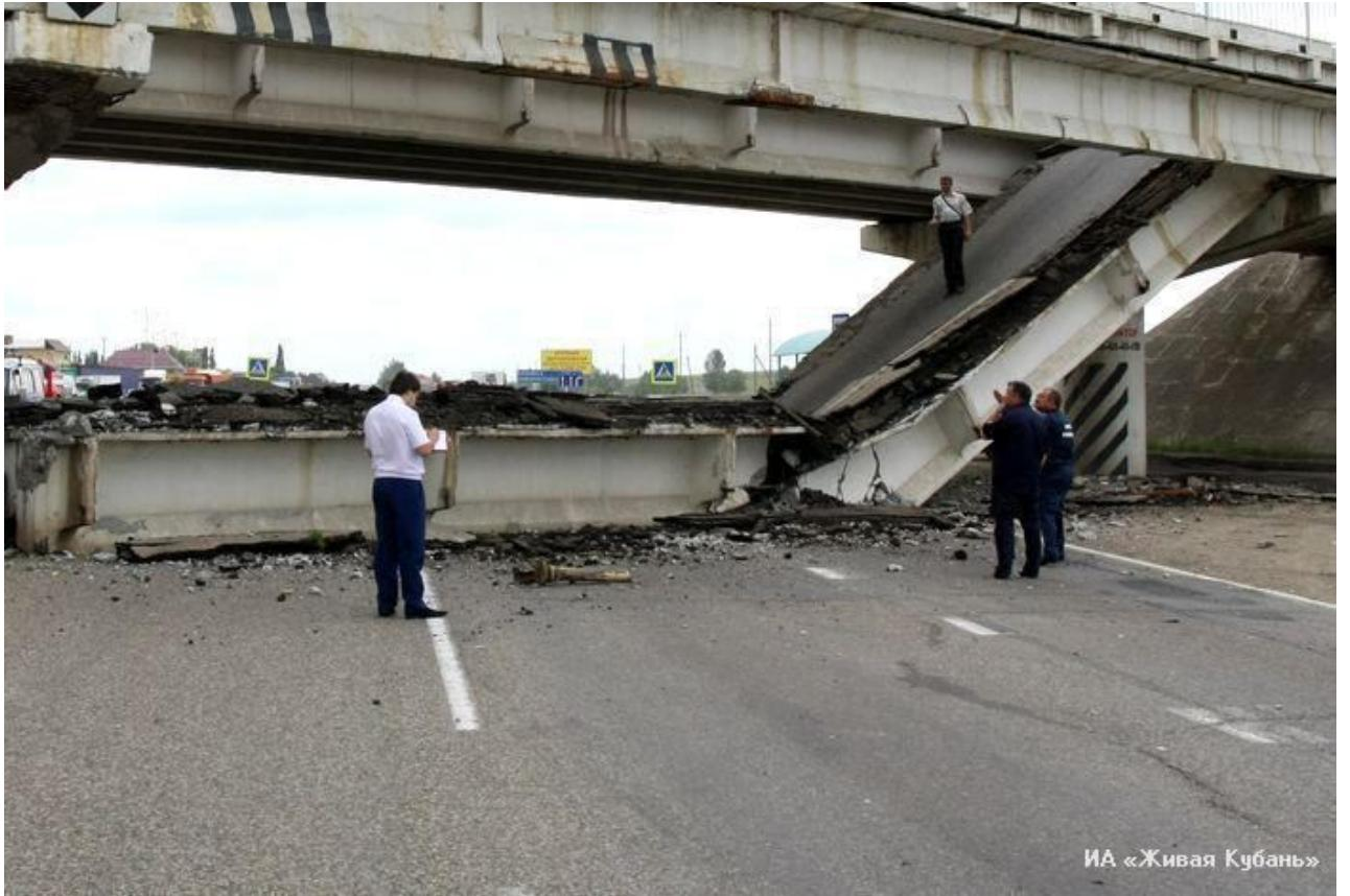
Рис.2. 20 мая 2010 г в республике Адыгея рухнул пролет путепровода через М-4. Видна огромная толщина лишнего слоя покрытия, вероятно, еще и коррозия арматуры – разрушение как будто произошло по арматуре (не видно выкрашивания сжатой зоны).
