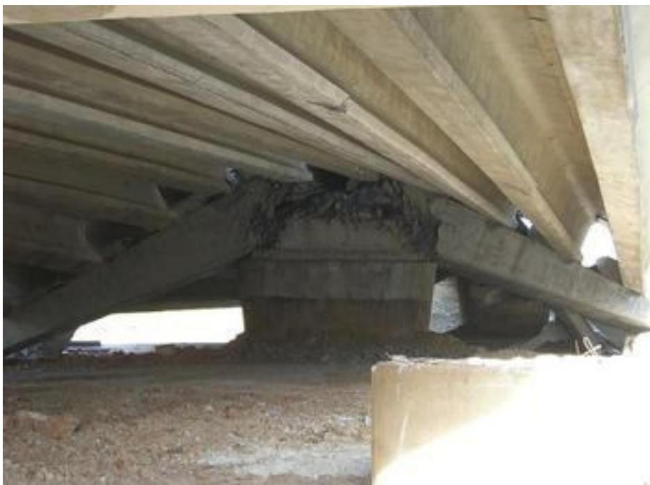
Рис.1. 04 сентября 2006 г рухнул строящийся путепровод через ж.д. в Екатеринбурге – разрушение сначала по бетону, потом – по арматуре (по некачественной сварке в растянутой зоне).
