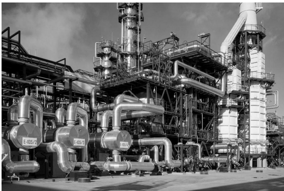
Рисунок 3.4 – Омский НПЗ. На переднем плане – блок кожухотрубных теплообменников
