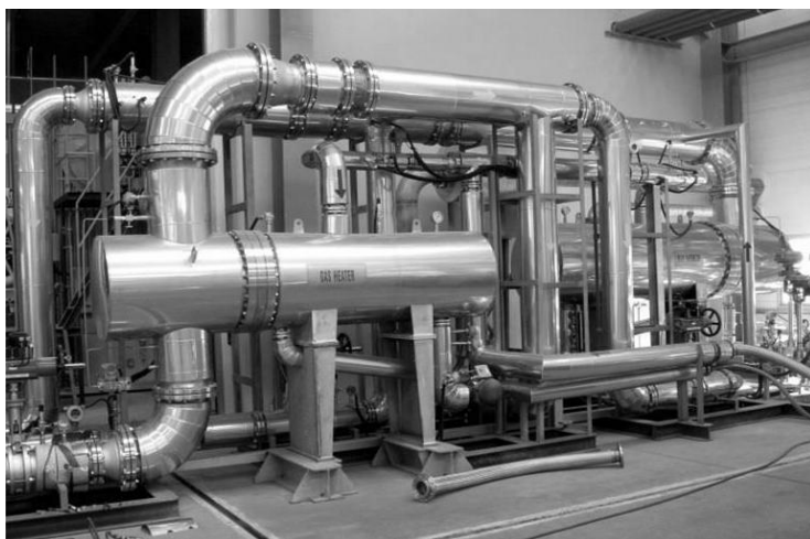
Рисунок 3.10 – Теплообменник - вымораживатель в установке производства СПГ
