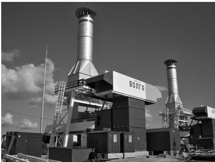
Рисунок 3.8 – Газоперекачивающий агрегат ГПА-16
