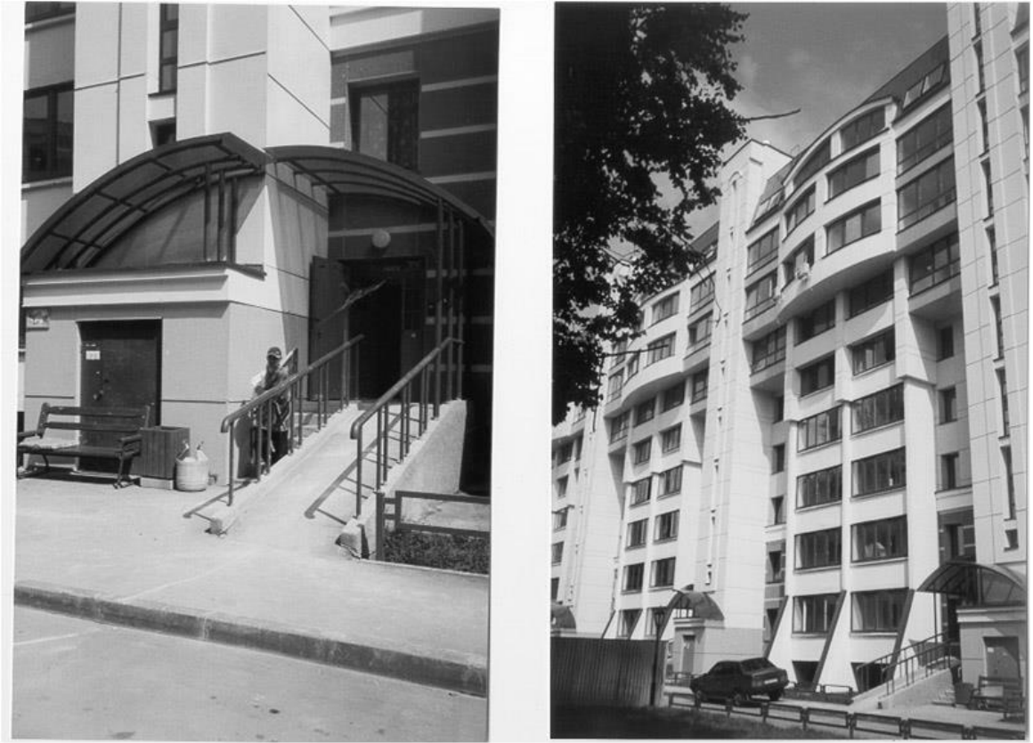
Рис.П.3.2 Реконструкция жилого 5-ти этажного дома серии 1-515 в г.Москве (с надстройкой четырех этажей). а- до реконструкции; б – после реконструкции
