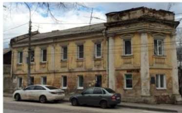
паз 10, Котляров, 44 (фасад со стороны ул. Сакко и Ванцетти)
