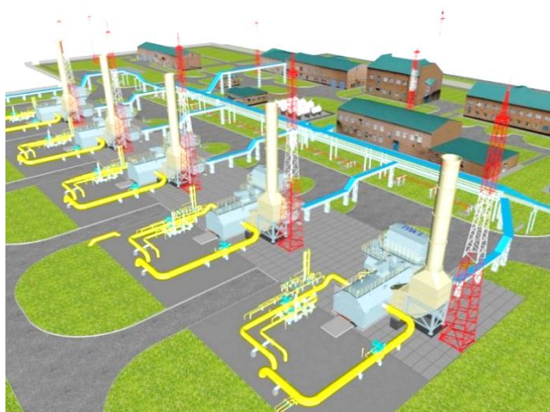
Рис. 1. Компрессорная станция природного газа
