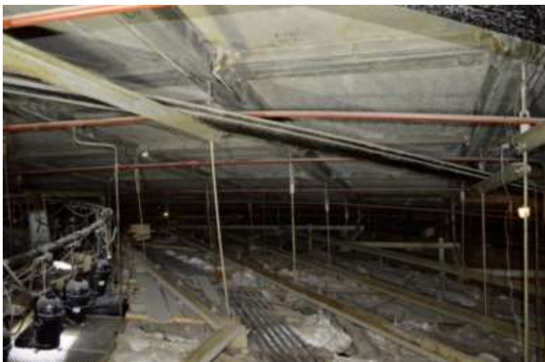
Рис. 6. Пространство под оболочкой, где происходило лазерное сканирование
