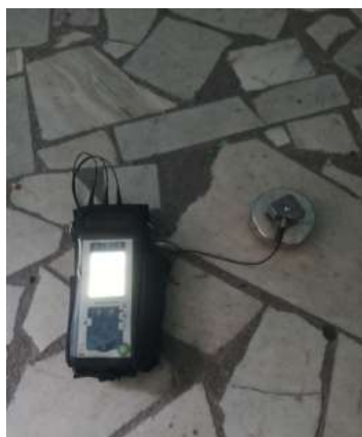
г) датчик на перекрытии перед входом в аудиторию
