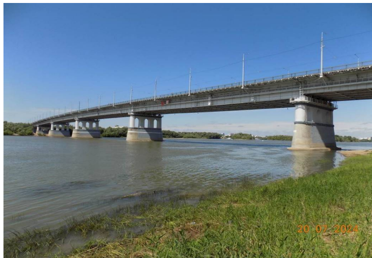
Рис. 1. Общий вид на Ленинградский мост через р. Иртыш в г. Омске (с правого берега)
