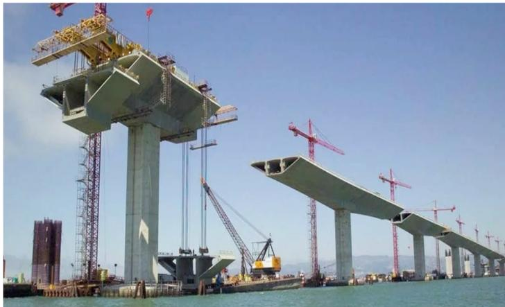
Рис. 1а. Замкнутая призматическая оболочка моста из сборного железобетона
