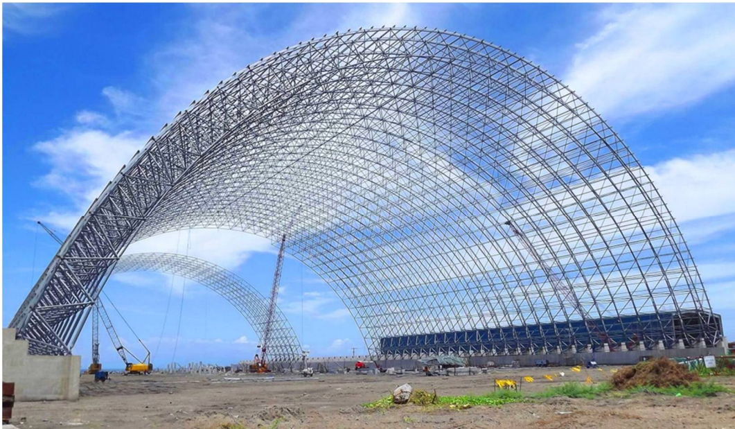
Рис. 1. Примеры построенных сетчатых оболочек цилиндрического типа
