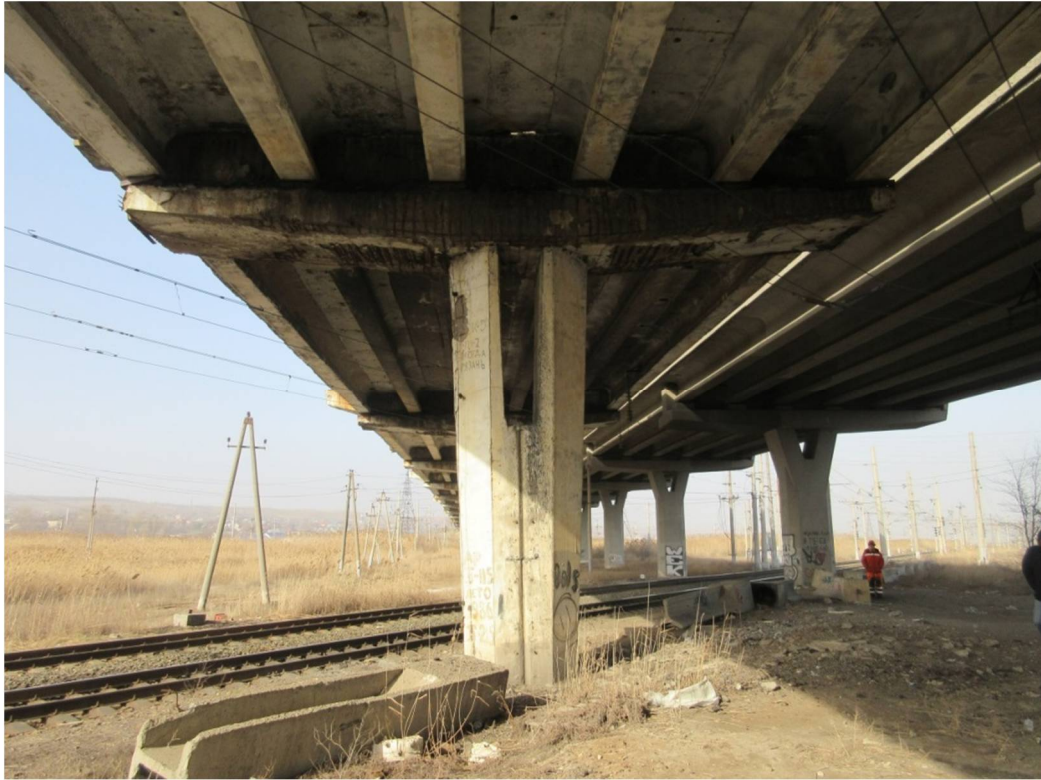
Рис. 1. Общий вид промежуточной стоечной железобетонной опоры путепровода
