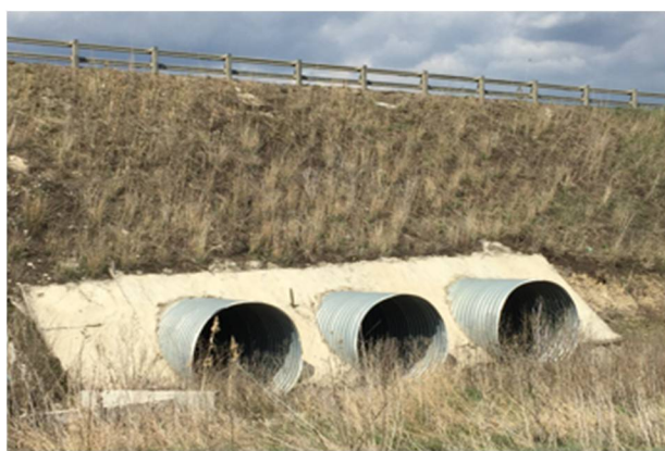
Рис. 3. Общий вид 2-й трехочковой трубы 3х1,8 м, высота насыпи 4,3 м
