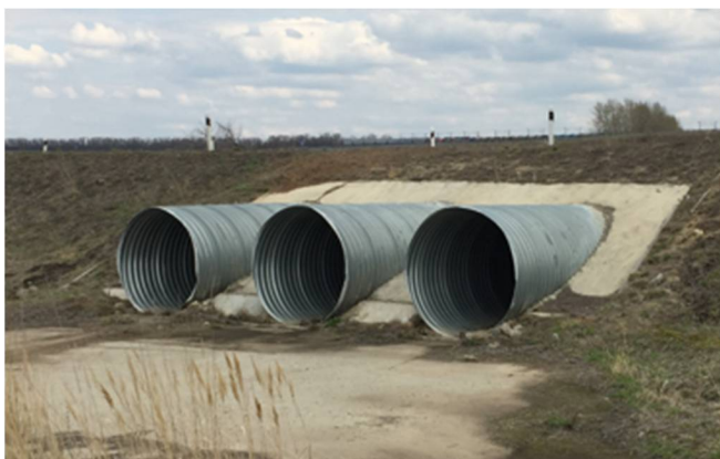
Рис. 2. Общий вид 1-й трехочковой трубы 3х1,8 м, высота насыпи 1,5 м
