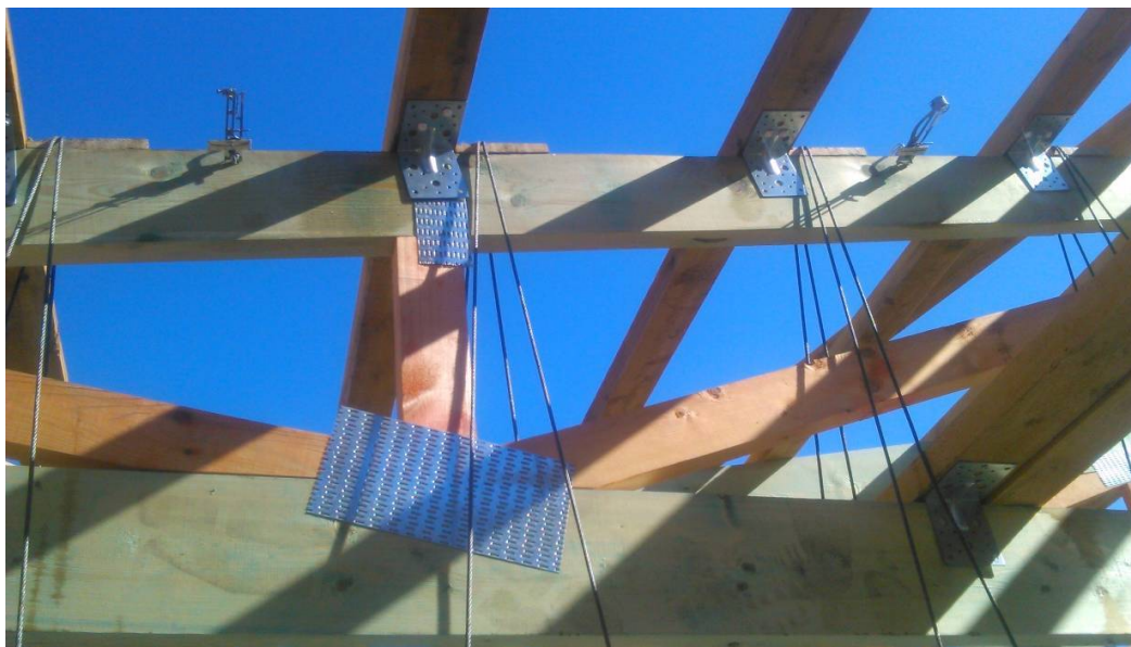
Рис. 4. Раскрепление верхнего пояса фермы из плоскости
