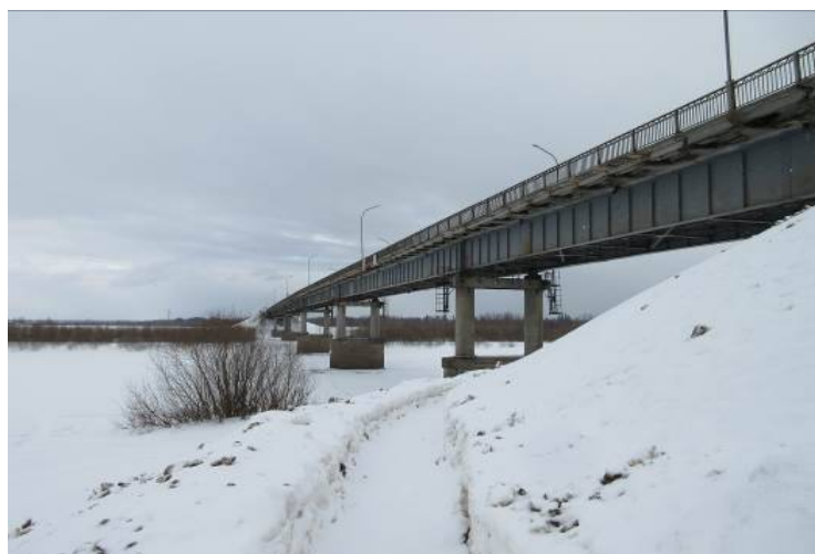
Рис. 1. Общий вид рассматриваемого автодорожного моста со сталежелезобетонным пролетным строением
