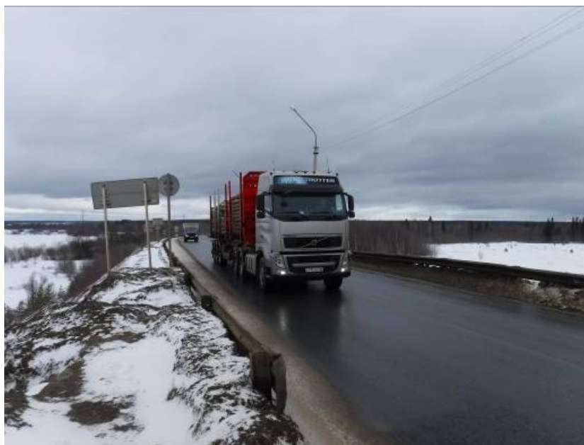
Рис. 3. Проезд тяжелого автопоезда при проведении динамического мониторинга неразрезного пролетного строения моста
