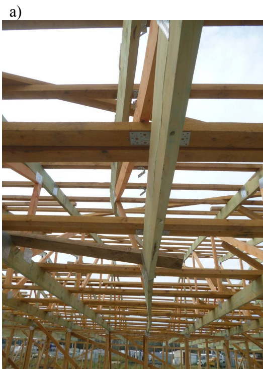
Рис. 6. Потеря несущей способности фермы: а) потеря устойчивости фермы №1 из плоскости; б) смятие древесины в приопорной зоне фермы №2
