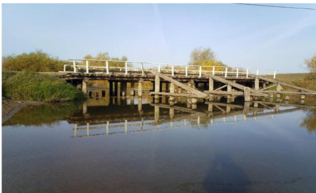
Рис. 1. Общий вид деревянного автодорожного моста
