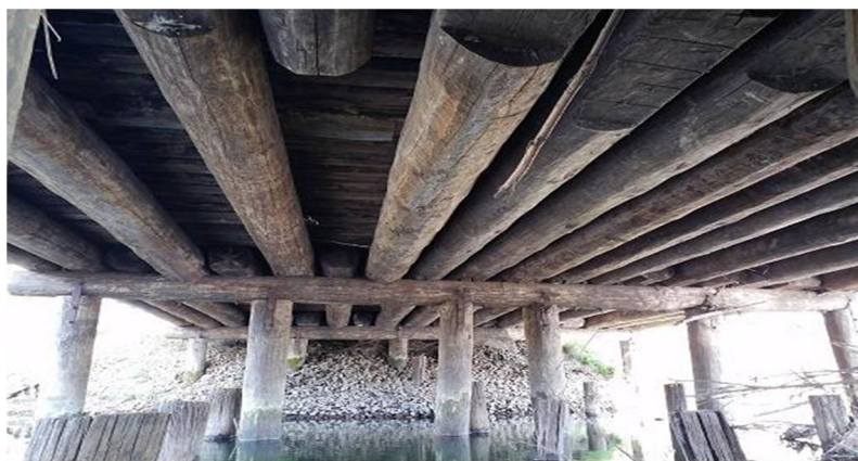
Рис. 2. Конструкция пролетных строений и опор моста
