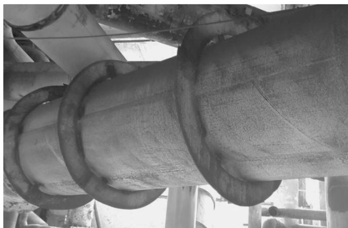
**Рис. 1.** Оперативно восстановленный и усиленный участок вакуумного паропровода после потери устойчивости в процессе эксплуатации, сахарный комбинат "Отрадинский", сезон 2016-2017
