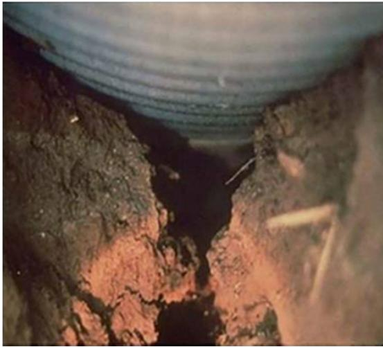
Рис. 9. Пример размытия основания [20]
