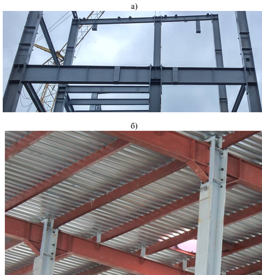
Рис. 1. Фланцевый жесткий узел сопряжения колонны с ригелем рамы, выполненный согласно серии 2.440: а) без вута; б) с вутом
