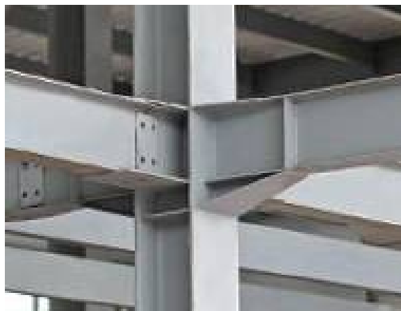
Рис. 3. Принципиальное решение принятого сварного рамного узла с вугом
