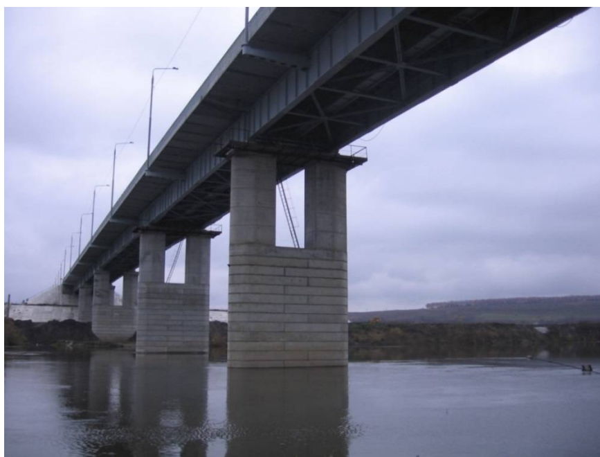
Рис. 1. Сотрудники НИЦ «ДОРМОСТ» при ВГАСУ на статических испытаниях автодорожного моста через реку Дон в Воронежской области
