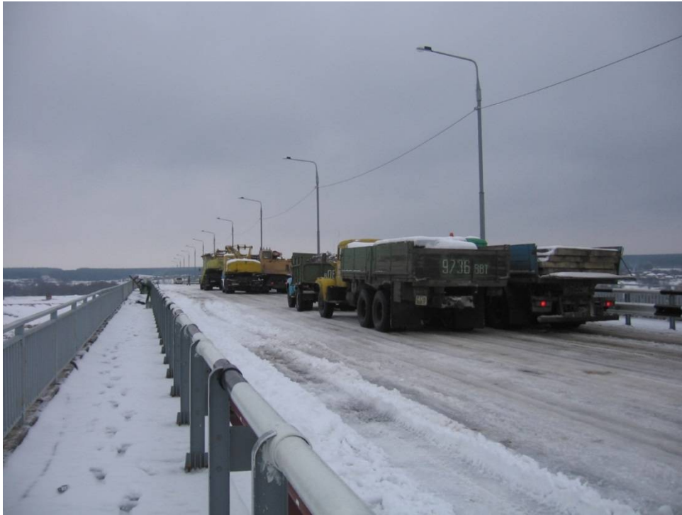
Рис. 2. Установка испытательной нагрузки на приемочных статических испытаниях моста через реку Дон (2006)
